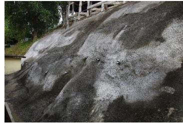
ダルマラージャ学校の斜面 (左：ショットクリート、右：法枠+植生工)
