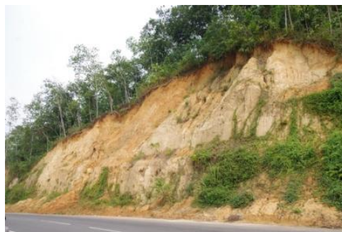
普及・実証事業施工現場予定地(ケーガッレバイパス)
