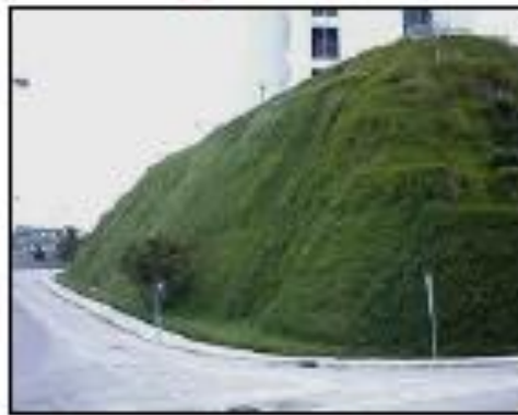
図 3-6 : NBRO の実施した切土法面の斜面緑化工 (Diyathalawa Township)
