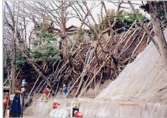
b) 連続繊維補強土工の施工状況
