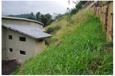
ダルマラージャ学校の斜面 (左：ショットクリート、右：法枠+植生工)
