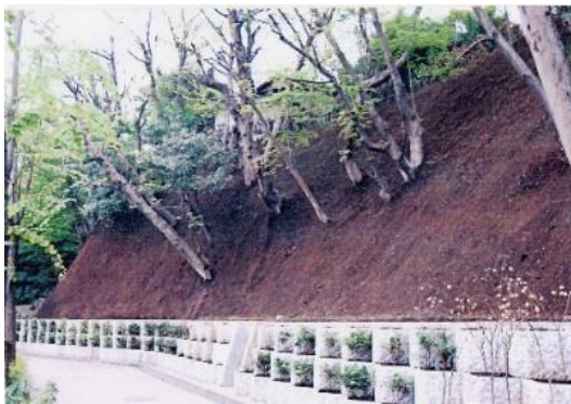
c) 施工完了
