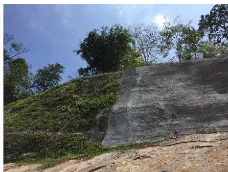
スリランカ 法面工事実施現場
