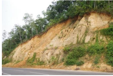
ケーガッレバイパスの斜面
