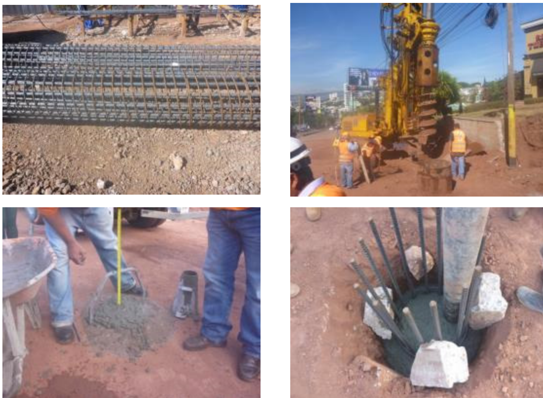
Figura 2.2.14 Situación de ejecución de obra de pilotes de concreto con barras de refuerzo por los constructores locales
