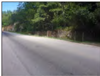
②国道の状況 起点から終点を望む
