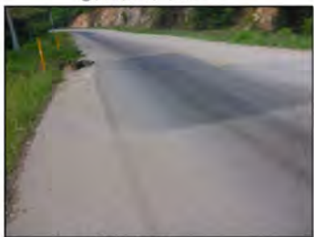
④路面の状況
