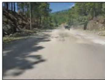
⑤国道の状況 起点から終点を望む
