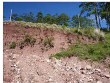
⑥ 地すべり頭部の滑落崖の状況
