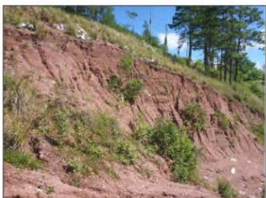
⑩ 地すべり頭部の滑落崖の状況
