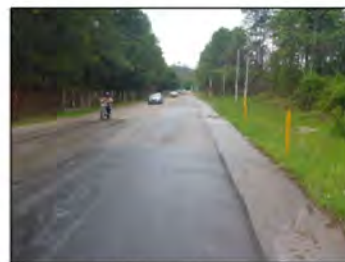
①国道の状況 終点から起点を望む
