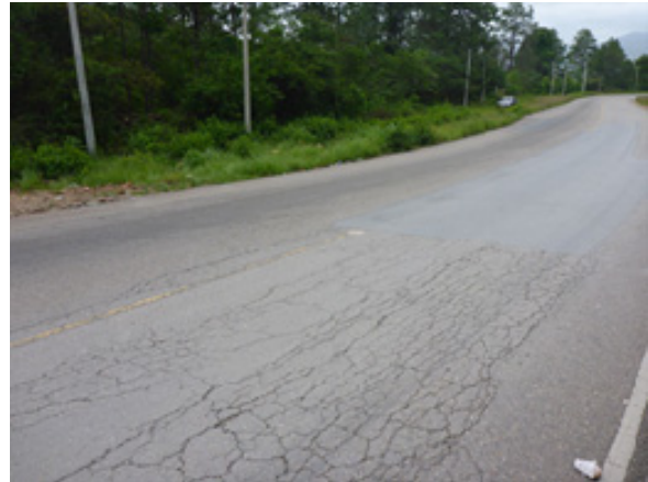
写真-8 Sta.22b-2 の状況
