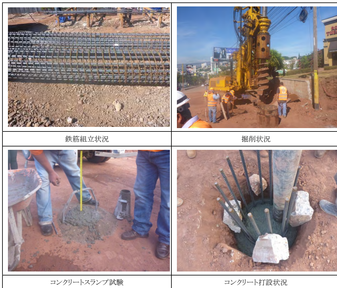
図 2.1.4 鉄筋コンクリート杭の施工状況
