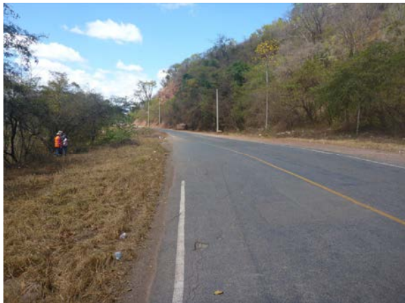
写真-11 Sta.63 の状況 終点より撮影
