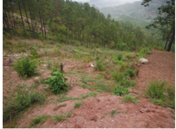
写真-2 Sta.14 地すべりの状況
