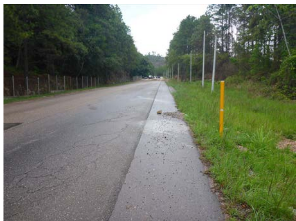
写真-6 Sta.22a の状況 終点側から撮影
