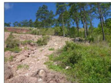
④ 右側部の状況
