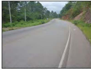
① 国道の状況 起点より終点を望む
