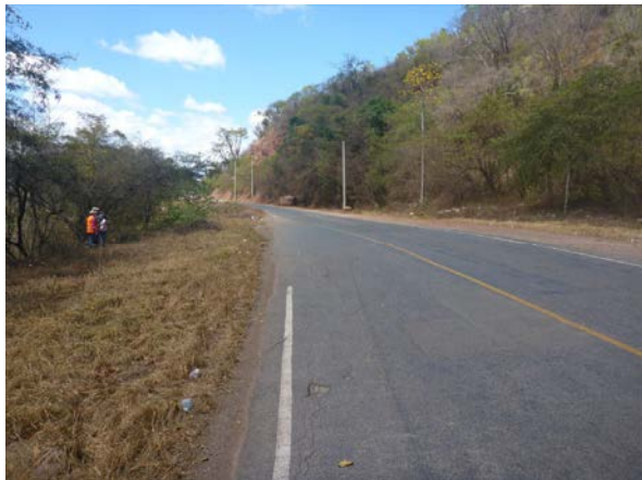
写真-11 Sta.63 の状況 終点より撮影
