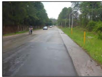
① 国道の状況 終点から起点を望む
