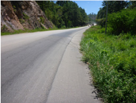
写真-7 Sta.22b-1 の状況
