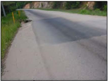
⑦ 路面の状況
