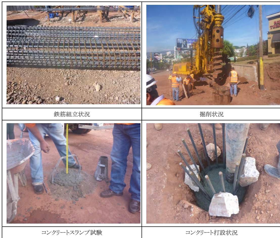
図 2.1.4 鉄筋コンクリート杭の施工状況
