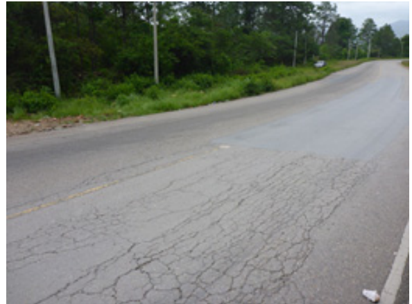
写真-8 Sta.22b-2 の状況
