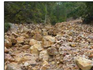
⑪ 河床の状況 (崩壊土砂が堆積している)
