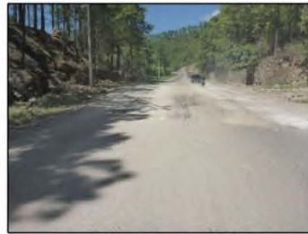
② 国道の状況 起点から終点を望む
