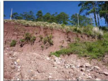
⑧ 地すべり頭部の滑落崖の状況
