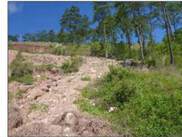
④ 右側部の状況
