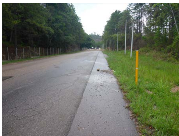
写真-6 Sta.22a の状況 終点側から撮影
