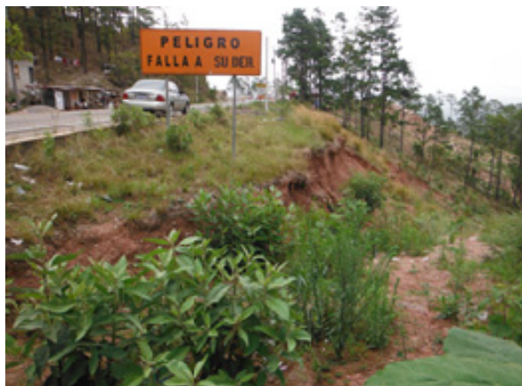
写真-1 Sta.14 地すべり頭部の滑落崖の状況
