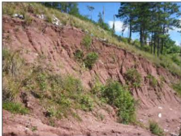
⑤ 地すべり頭部の滑落崖の状況
