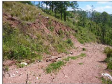
④ 地すべり頭部の滑落崖の状況
