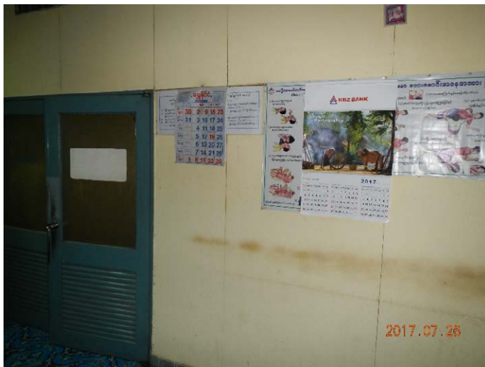
写真：コントロールルーム壁面
