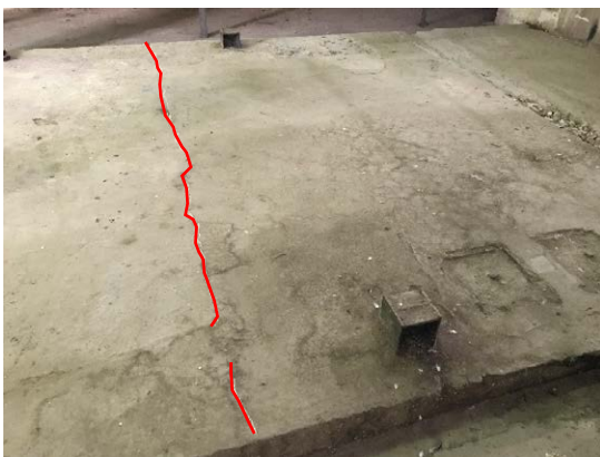
箇所3 クラック幅 最大 1.2mm
