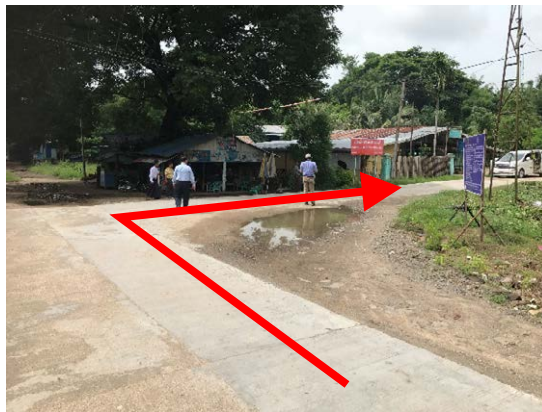
Point 1-1 コーナーの様子 道路幅：4.4m（荷揚げ場方向） 3.7m（発電所方向） ただし、3.7m側道路脇から民家まで6.3m
