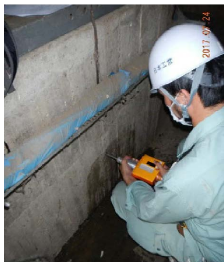
撮影：調査団 写真 シュミットハンマーによる圧縮強度測定の様子
