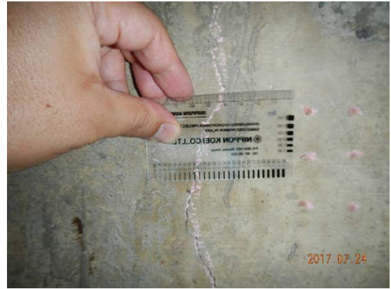
箇所2 クラック幅 最大 0.45mm
