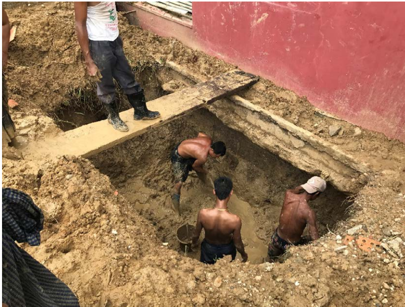
写真：ピット掘削状況
