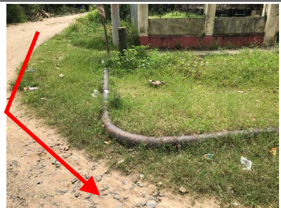
Point 1-1 コーナーにある給水管 輸送時に注意が必要であるが曲がりに影響はないと思われる。
