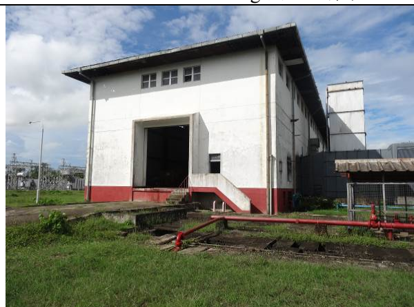
Photo-9 西側搬入口 (幅 5m,高さ 5m,段差 1m)
