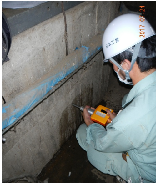
写真 シュミットハンマー測定の様子
