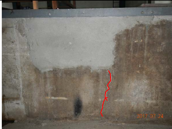
箇所2 クラック幅 最大 0.45mm
