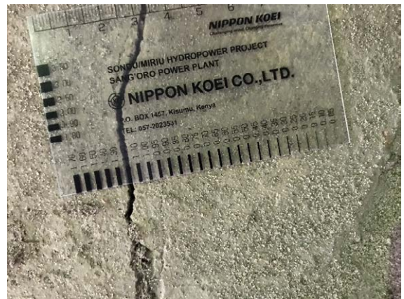
箇所3 クラック幅 最大 1.2mm
