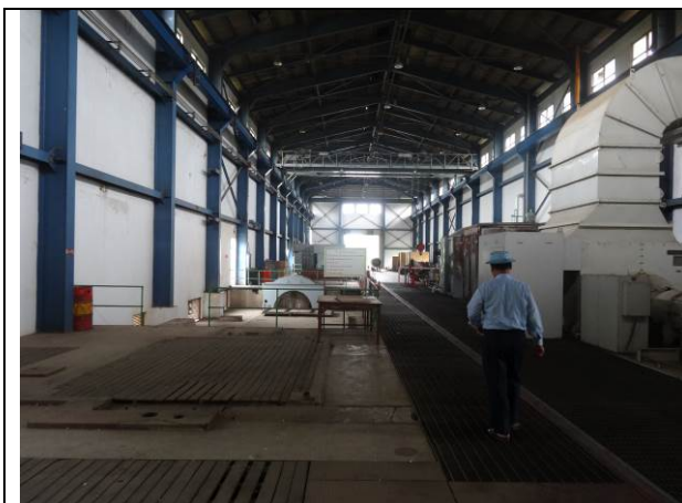
Photo-7 Service Building 側より撮影
