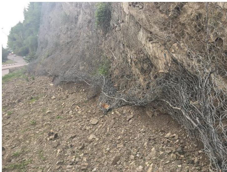
図 4-26 設置済工法の状況
