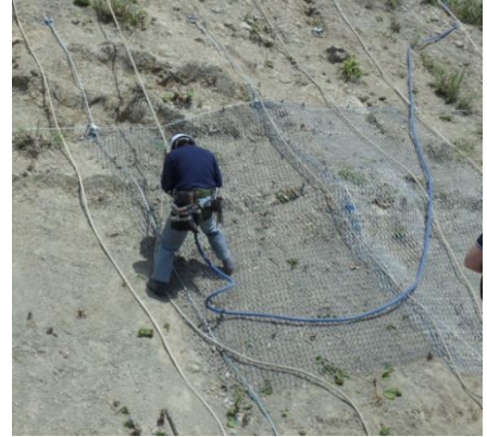
図 2-1 MN 施工作业
