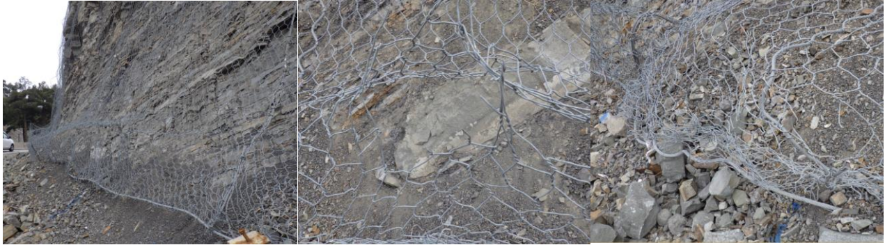
図 2-2 競合他社製品の破損状況
