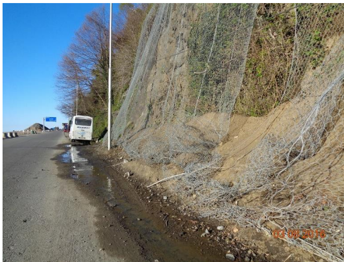
図 4-27 Batumi に設置された Maccaferri 社製品の状況
