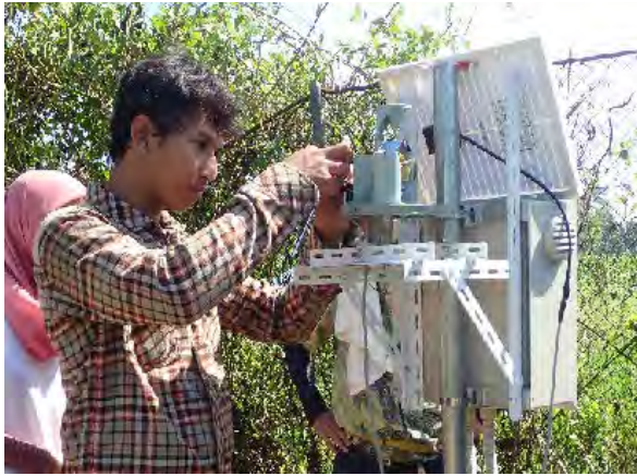
ソーラーパネル設置作業 (2016年5月)
