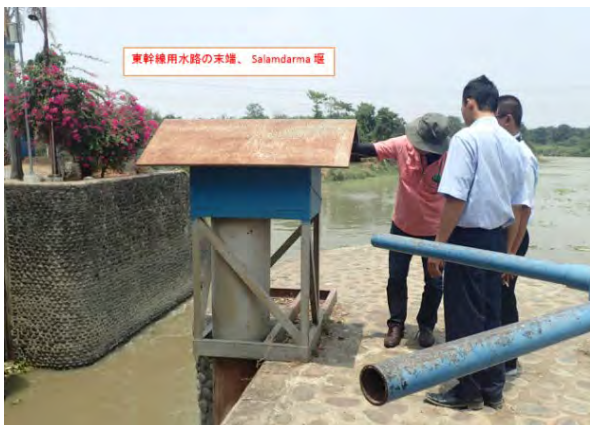
水位計設置方法についての協議 (2015年9月)
