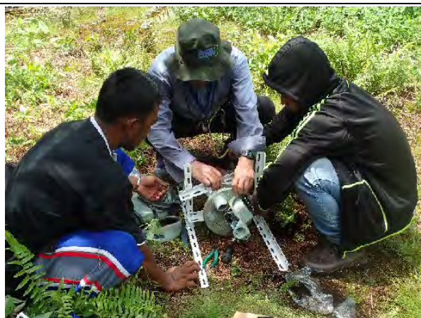
雨量計設置作業 (2016年5月)
