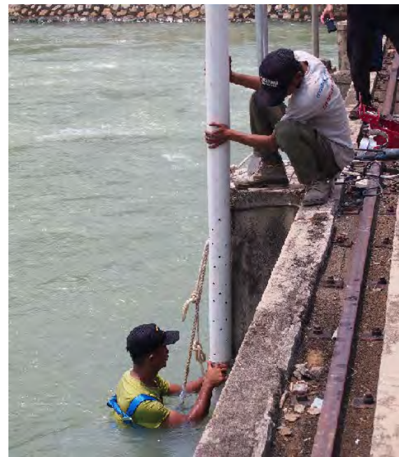
水位計設置作業 (2016年8月)
