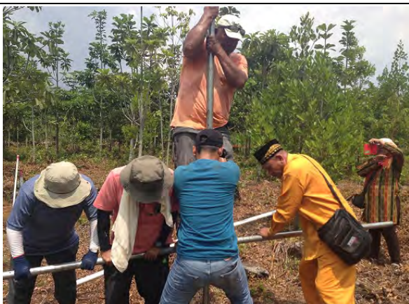
SESAME 用支柱設置作業 (2016年5月)
