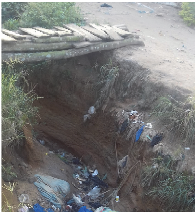
フェーズ1 道路改修サイトにおける 未舗装道路の浸食
