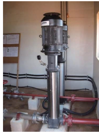
同給水システムの水源のポンプ場
