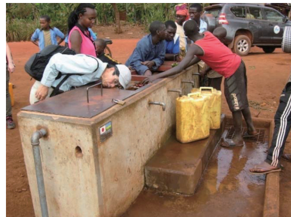
同給水システムの公共水栓の一つ
