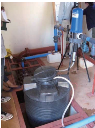
同給水システムの配水池にある塩素注入機
