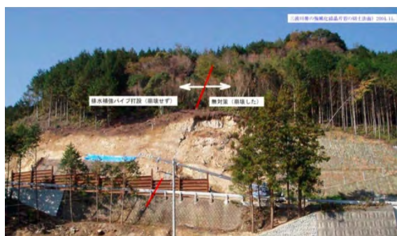
施工箇所 (左) では崩壊は生じなかったが、 未施工箇所 (右) で崩壊が生じた事例
