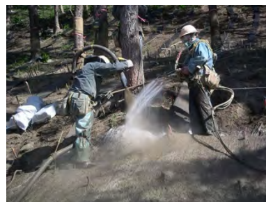
樹木伐採を行わず施工が可能 出典：日特建設 HP
