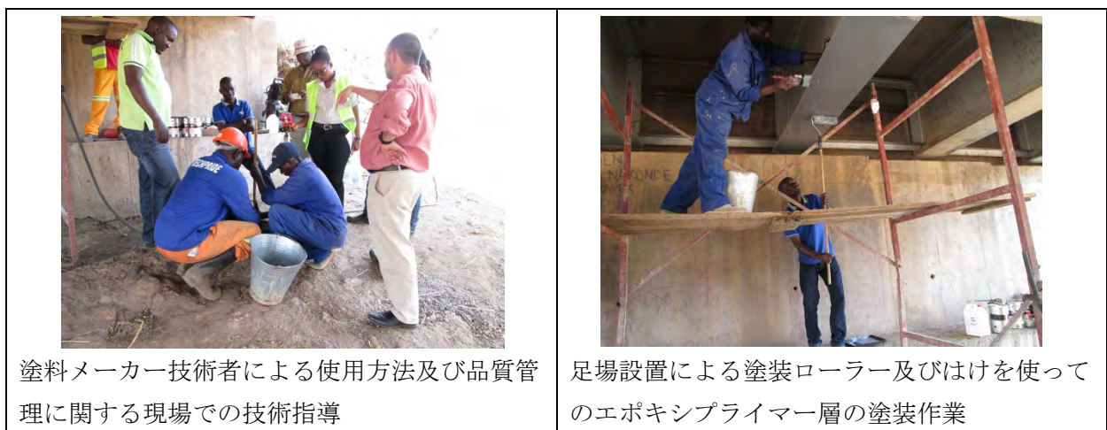
図 II-17 鋼橋再塗装 OJT
