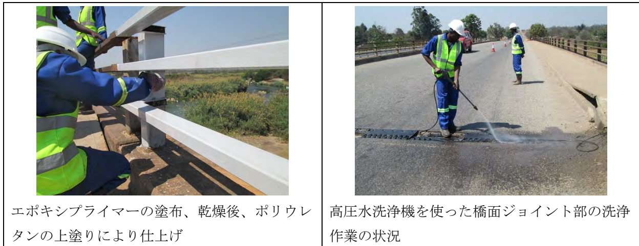
図 II-6 ドライラン実施 (2/2)
