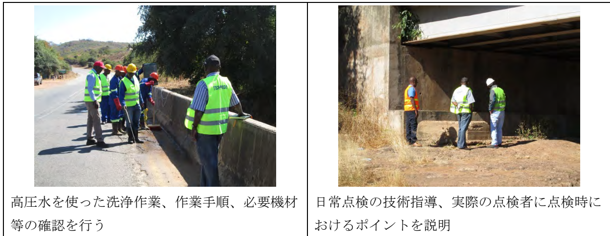
図 II-14 日常点検、清掃及び草刈作業 OJT
