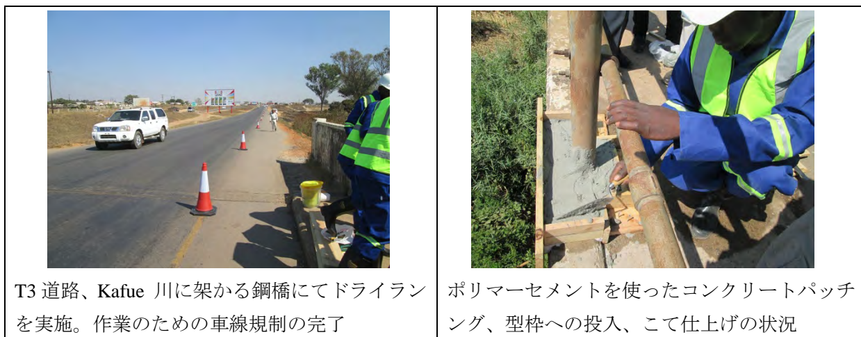
図 II-5 ドライラン実施 (1/2)
