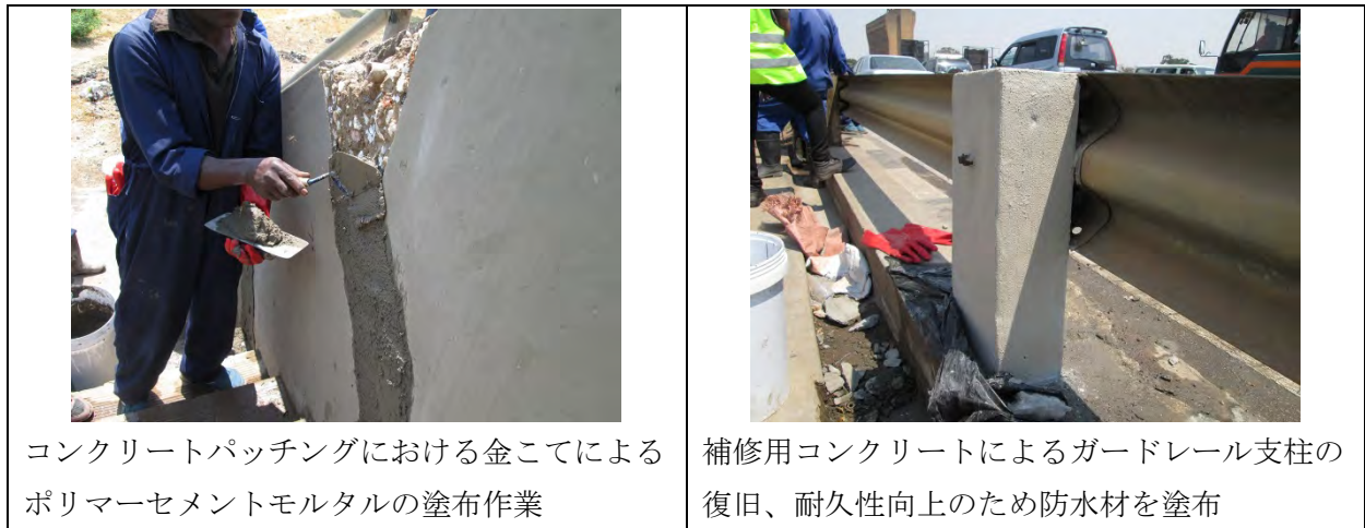
図 II-16 コンクリート補修 OJT (2/2)
