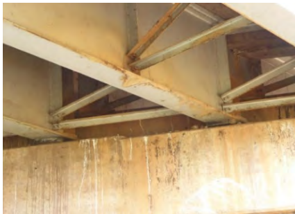
鋼桁の腐食
