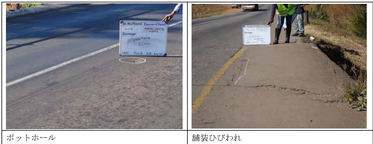
図 II-36 舗装の損傷
