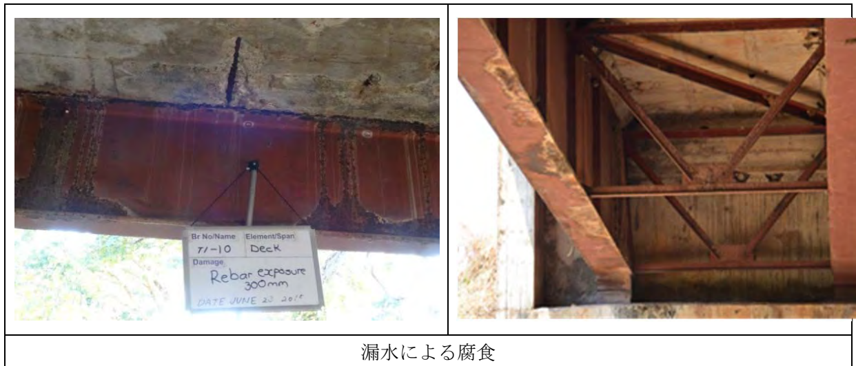
図 II-28 鋼桁の腐食
