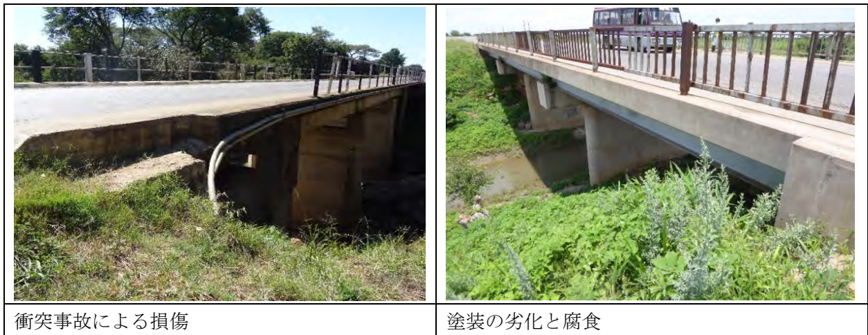
図 II-35 ガードレールの損傷
