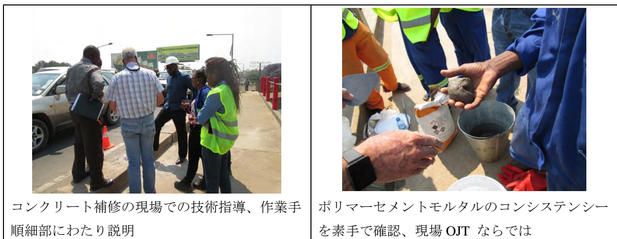
図 II-15 コンクリート補修 OJT (1/2)
