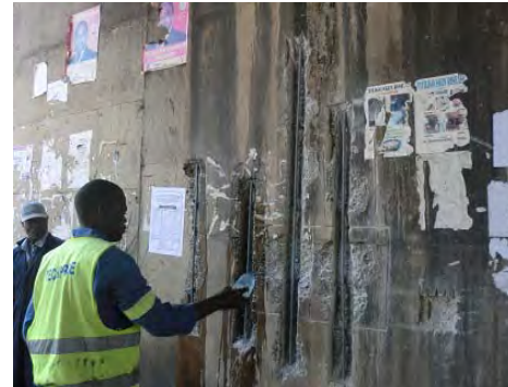
コンクリート補修作業
