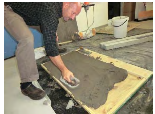
パッチング補修工事のデモ (BASF) (コテ仕上げ)
