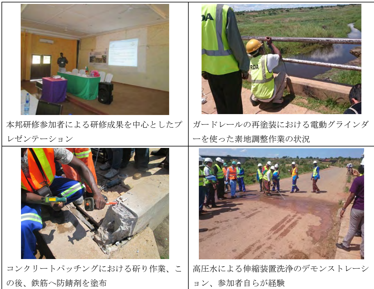
図 II-12 第3回橋梁日常維持管理 OJT (1/2)
