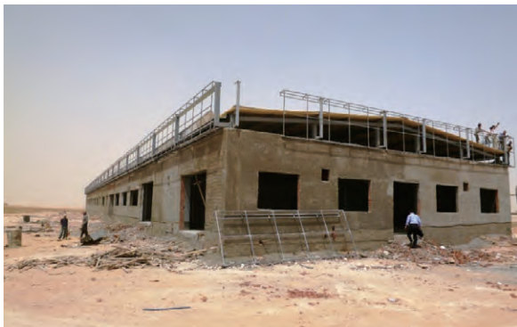
建設中の新研究棟
