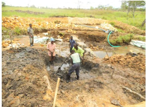
**取水口部分の掘削**：設計標高まで取水口部分を掘削（北部州ムバラ郡 Kawama サイト）
