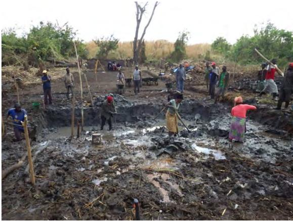
**エプロン部基礎の掘削**：バケツで排水しつつ、クワやシャベル、ツルハシなどを用いてエプロン部基礎を掘削。掘削は強固な基盤が出るまで行う（ムチンガ州ムピカ郡 Lubanga サイト）
