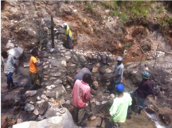
**左岸側アバットメントおよび取水口の建設：**左岸側アバットメントと取水口建設のための練り石積み作業。建設中、河川は本流に仮廻しされる（北部州ルイング郡 Mufili Chibwale サイト）
