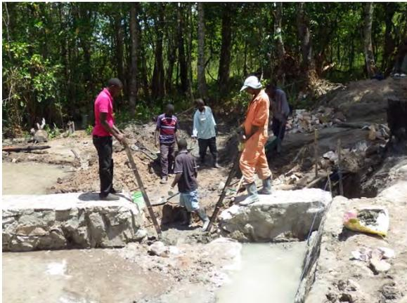
**取水口部角落とし枠の設置：**取水口部に鉄製の角落とし枠が設置される（北部州ムボロコソ郡 Mpela サイト）
