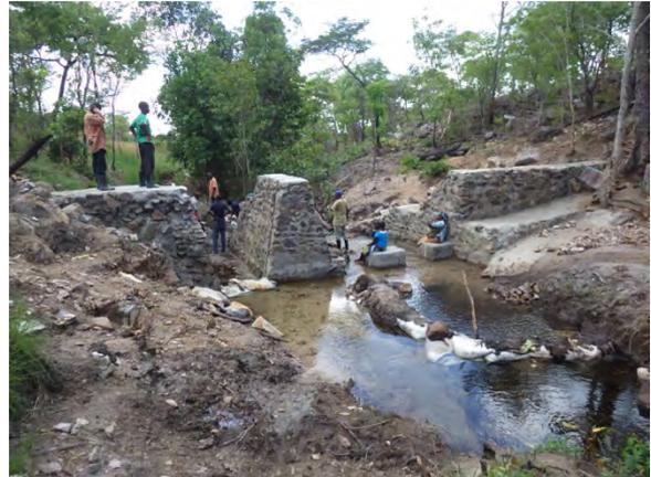
**上流側からみた練り石積み堰：**練り石積み堰の主要構造物が完成した（北部州ルイング郡 Mufili Chibwale サイト）
