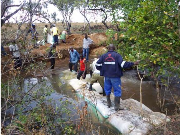
**仮締め切り堤の建設**：サンドバッグを利用して仮締め切り堤を建設（北部州ムバラ郡 Kawama サイト）
