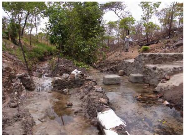
**取水口部分における角落とし枠の設置**：右岸側アバットメントの概ねの完成と同時に取水部の工事を開始。まずは角落とし用の鉄製フレームを設置。
