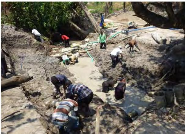
**恒久堰基礎部の掘削**：地下水の浸出により掘削工事が難航した。そのためエンジンポンプを稼働して排水をしながらの掘削工事となった（北部州ンサマ郡 Munyele サイト）
