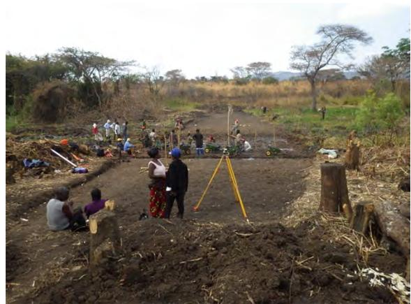
**掘削準備および仮ベンチマークの設置：** 木や草を取り除き、表土剥ぎを行った後、仮ベンチマークを設置。（ムチンガ州ムピカ郡 Lubanga サイト）
