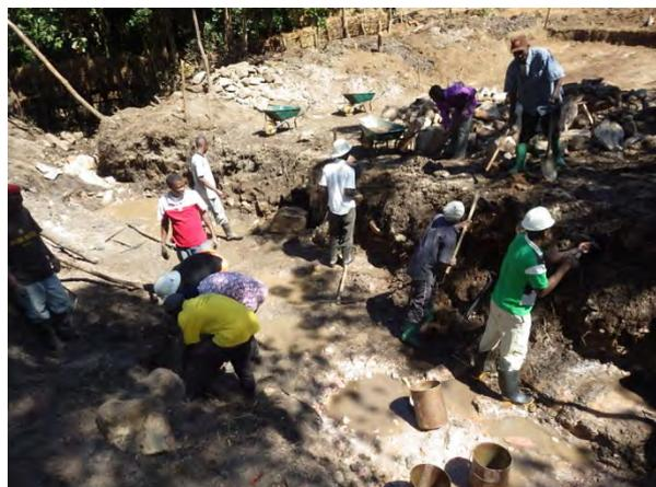
バケツを使った排水作業とエプロンの掘削状況 (カサマ郡 Musanda)
