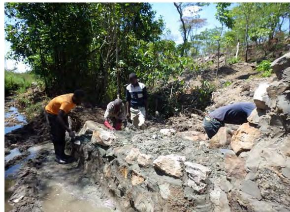
**取水路付近の練り石積み作業：**洪水による浸食を防ぐため、取水路上流端はより堅固に建設する必要がある（北部州ルイング郡 Mufili Chibwale サイト）
