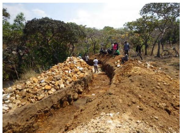
**仮廻し水路の完成：** ドライワークのための作業場所を確保するため、仮廻し水路を掘削（完成）（北部州ムバラ郡 Kawama サイト）
