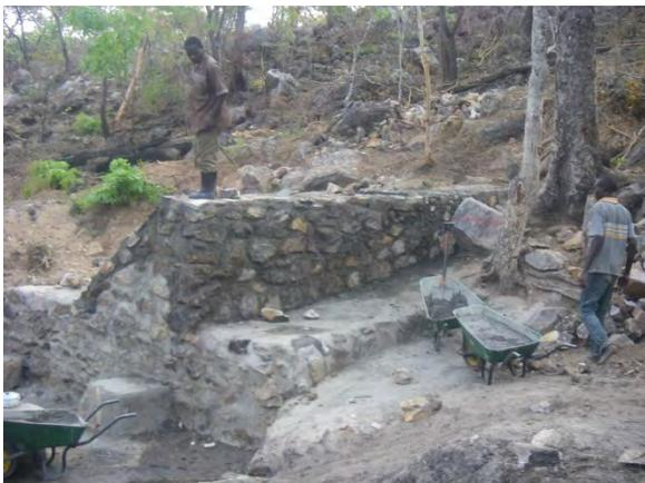
**右岸側アバットメントの完成**：設計標高までの練り石積みが完成した右岸側アバットメント。
