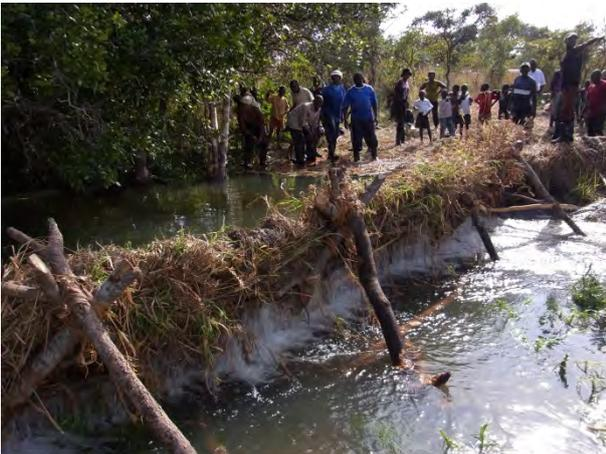
**簡易堰建設にかかる実地研修**：このような形式による堰の利点として、完璧に止水しないという点が挙げられる。これによりある程度の水は下流へと流れていく。
