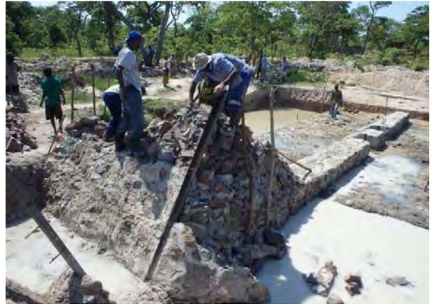
**アバットメントの建設**：左岸側のアバットメント建設中の状況。角落とし用の鋼製フレームが取り付けられている（ルアブラ州マンサ郡 Kalila サイト）
