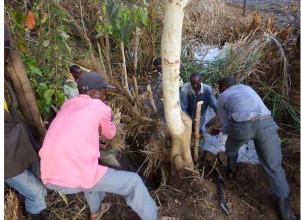
**仮締め切り堤の建設**：簡易堰の技術を応用して仮締め切り堤を建設（ムチンガ州ナコンデ郡 Musanza サイト）
