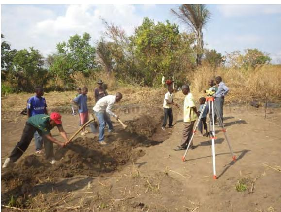
**仮廻し水路の掘削：** ドライワークのための作業場所を確保するため、仮廻し水路を掘削（ムチンガ州 Musanza サイト）
