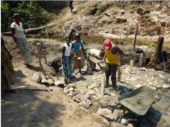
**洪水吐用角落とし枠の設置およびエプロン部の練り石積み**：熟練工が鉄製の角落とし枠を設置する一方、女性達はエプロン部の練り石積みを行っている（北部州ルイング郡 Mufili Chibwale サイト）
