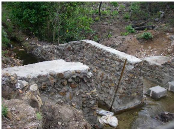
**取水口：**取水路部分の練り石積みが完成。角落とし用のフレームが設置された。その後、左岸側擁壁の護岸と水路の補修が行われた（北部州ルイング郡 Mufili Chibwale サイト）
