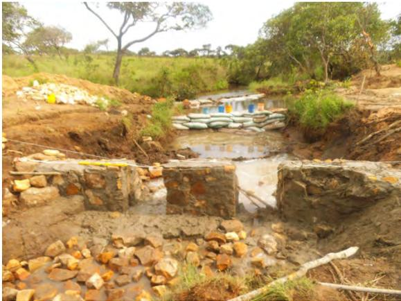
**角落としが設けられて完成した洪水吐**：角落とし枠が設けられて完成した洪水吐（北部州ムバラ郡 Kawama サイト）
