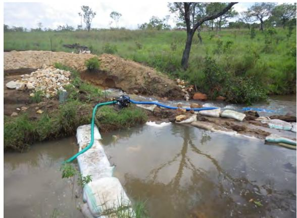
**エンジンポンプによる排水**：仮締め切り堤からの漏水が激しいため、エンジンポンプによる排水に切り替え（北部州ムバラ郡 Kawama サイト）
