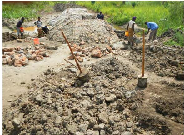
**盛土締め固めのためのランマー：**ランマー（締め固め器）を用いて盛土部分の締め固めを行う（ムチンガ州 Lubanga サイト）
