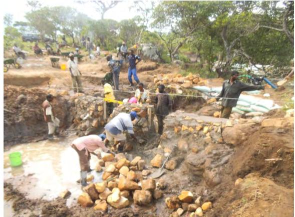
**練り石積み堰の洪水吐部分の建設**：洪水吐の主要部分が練り石積みにより建設されている（北部州ムバラ郡 Kawama サイト）
