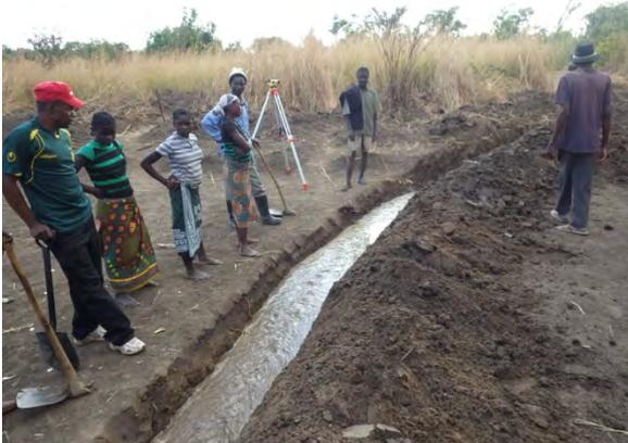
**仮廻し水路**：仮締め切り堤が完成し、仮廻し水路により河川の水を迂回させる（ムチンガ州ナコンデ郡 Musanza サイト）
