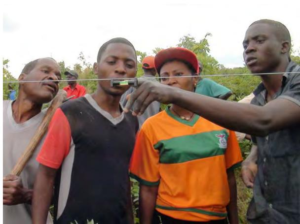
**水路線形にかかる実地研修**：水準器で水平を測りながら適正な水路方向を調整する。水準器を読み取る人間の指示に従い、杭を持った人間が左右に動く。
