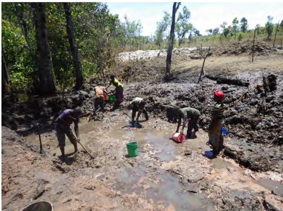
**バケツによる排水**：仮締め切り堤からの浸水がそれ程酷くない場合にはバケツを用いて排水を行う（北部州ムポロコソ郡 Mpela サイト）
