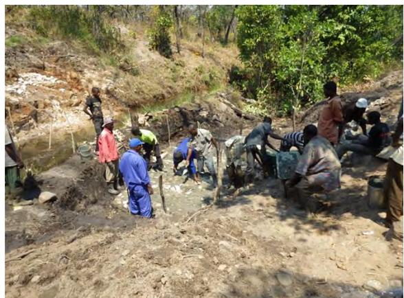
**エプロン部の練り石積み**：掘削されたエプロン部に石を配置し、その隙間にモルタルを充填する（北部州ルイグ郡 Mufili Chibwale サイト）
