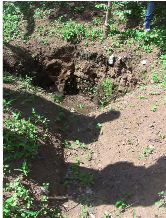
iv) Trincheras de infiltración: Pequeña zanja transporta agua de lluvia hasta allí para infiltrarla.
