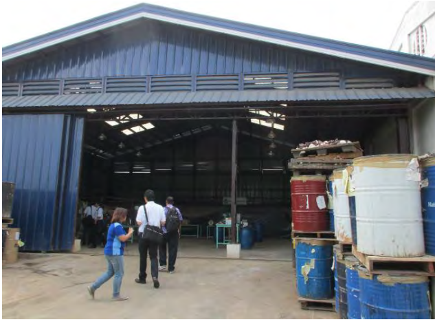
(a) 現地パートナー候補企業の E-waste 保管・解体施設
