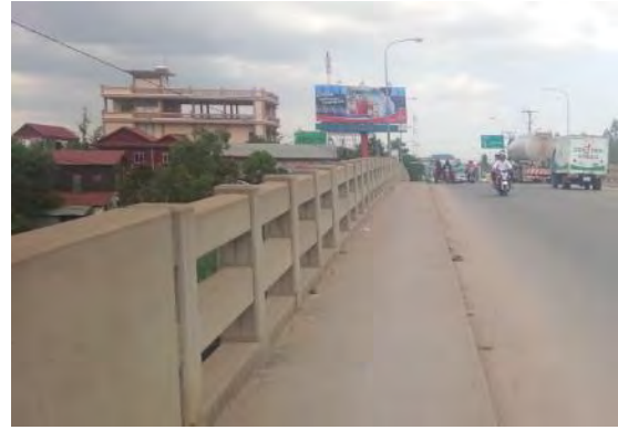
(b) 歩道有りの橋梁の高欄防護柵
