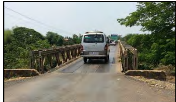
【写真 14】Peam Te 橋 民家が近く交通量が多いものの狭幅員
