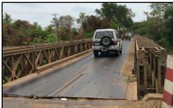
【写真 8】Prek Rus 橋 桁端部の段差および鋼板による補修跡
