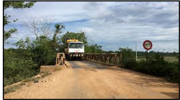
【写真 10】Anlong Khle 橋 挟幅員により、交互通行が強いられている。
