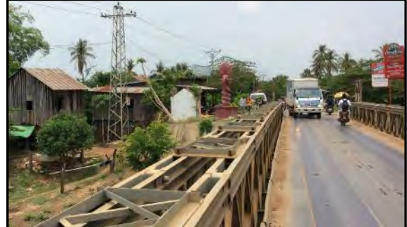
【写真 12】Prek Chhloung 橋 挟幅員かつ、交通量が多い
