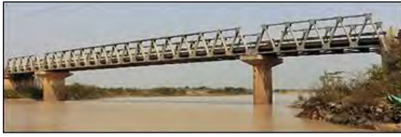
【写真 1】Ba Baong No.2 橋 3 径間単純下路式ポニートラス橋
