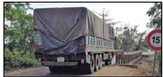
【写真 6】Prek Sandan 橋 規制荷重 15t を超える車両が多く通行している。
