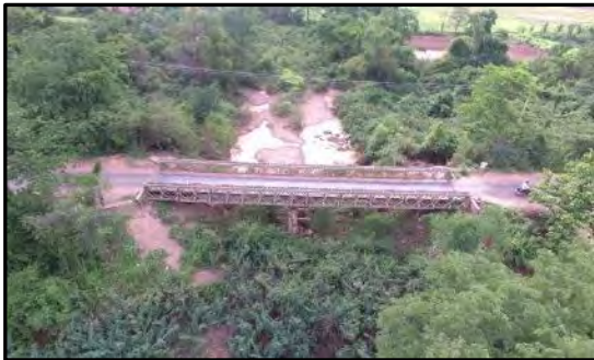
【写真 5】Prek Sandan 橋 2 径間単純ベイリー橋
