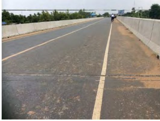
(a) 歩道無しの橋梁の高欄防護柵
