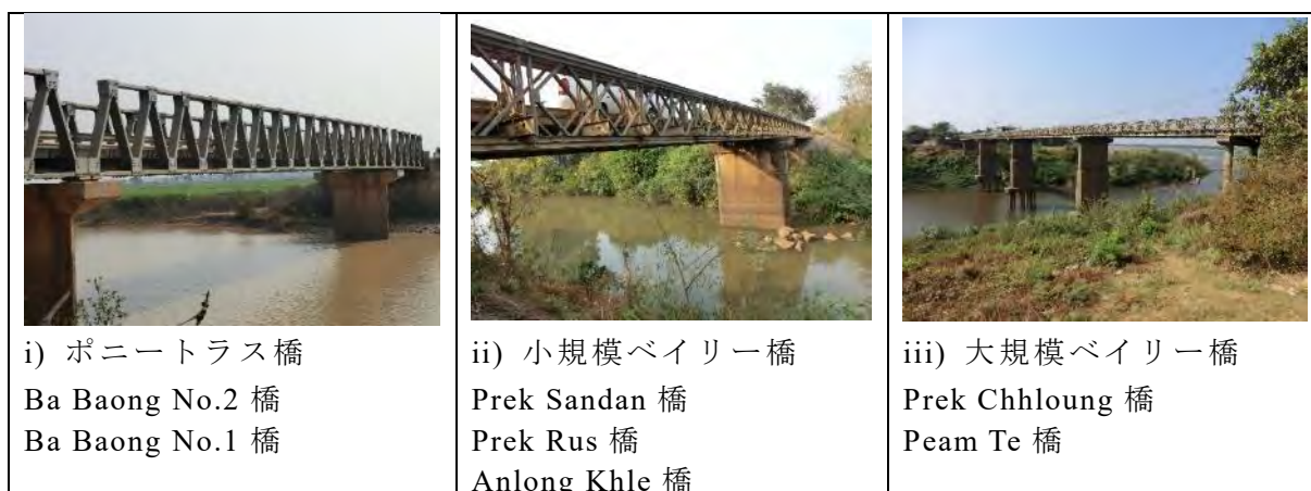
写真 3.2-1 既存橋の状況
