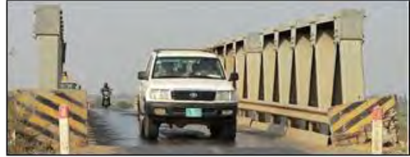
【写真 2】Ba Baong No.2 橋 床版は鋼板であり、車両走行時の衝撃音が大きい。
