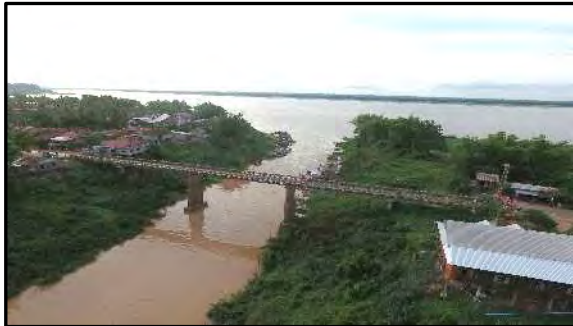
【写真 11】Prek Chhloung 橋 5 径間単純ベイリー橋
