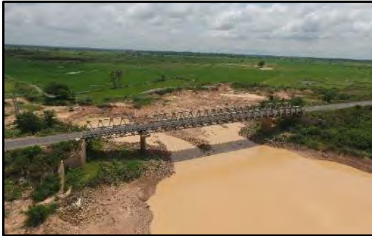
【写真 3】Ba Baong No.1 橋 3 径間単純下路式ポニートラス橋
