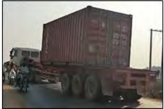
【写真 4】Ba Baong No.1 橋 幅員が狭く交互交通を余儀なくされる。
