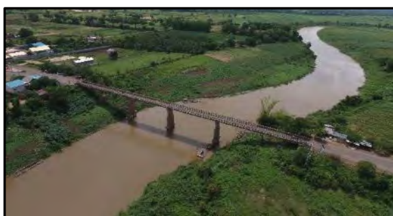
【写真 13】Peam Te 橋 6 径間単純ベイリー橋
