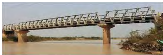
【写真 1】Ba Baong No.2 橋 3 径間単純下路式ポニートラス橋
