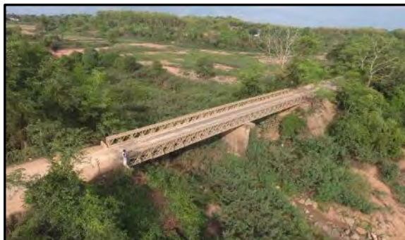
【写真 9】Anlong Khle 橋 2 径間単純ベイリー橋
