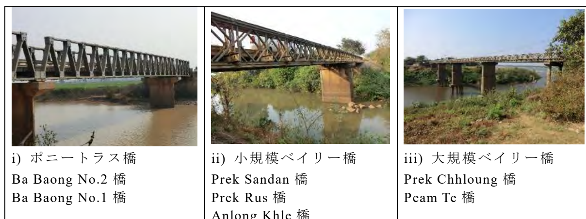
写真 3.2-1 既存橋の状況
