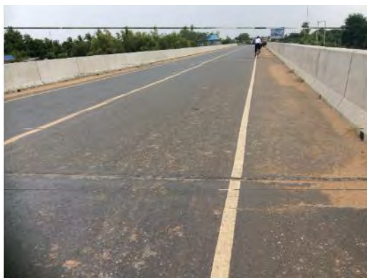
(a) 歩道無しの橋梁の高欄防護柵
