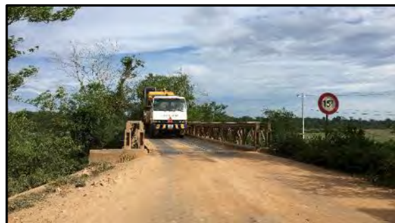
【写真 10】Anlong Khle 橋 挟幅員により、交互通行が強いられている。
