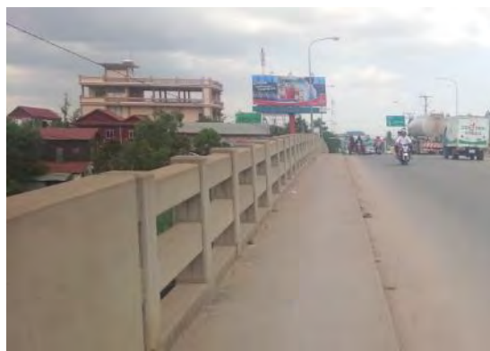
(b) 歩道有りの橋梁の高欄防護柵
