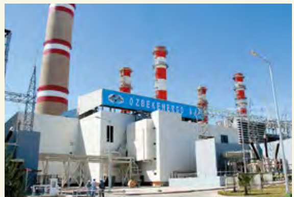
ウズベキスタンの中核発電所であるタリマルジャン火力発電所
