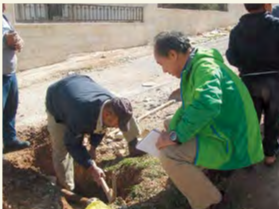
ヤムルーフ水道公社職員による配水管の漏水調査
