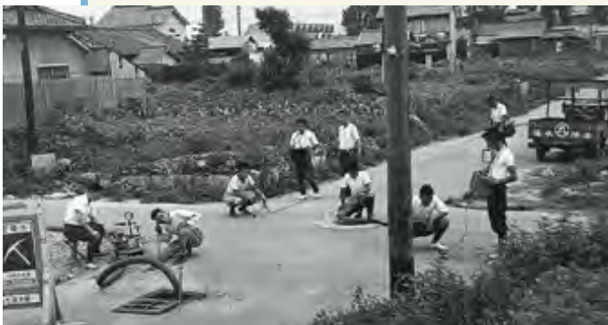
終戦後の漏水調査（名古屋市上下水道局、1949年頃）
