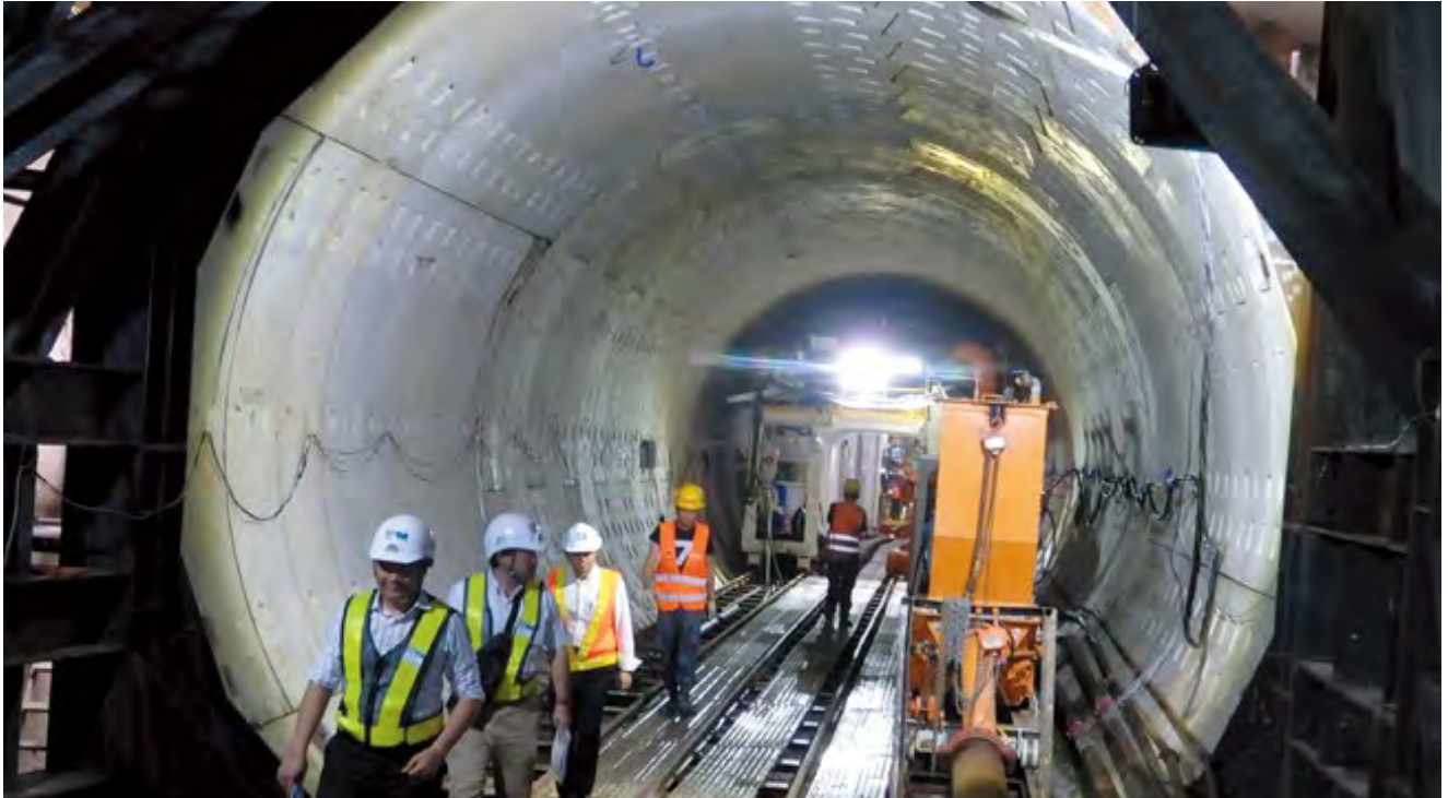
ベトナム：ホーチミン市都市鉄道1号線建設現場。シールドトンネル工法による地下トンネル工事（オペラハウス～パソン間）
