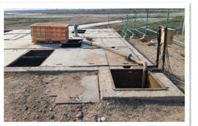
CGA 工場から排出された回収上液がパイプを通じ中和槽に貯められて石灰を加えて中和処理が行われる。2016/10/26
