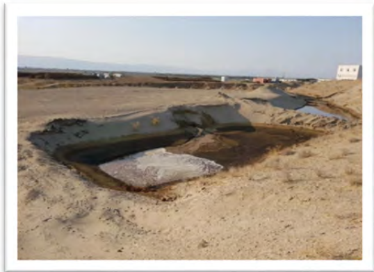
CGA 工場付近に掘削されたスラッジプール。中和槽から送られた回収上液を乾燥、スラッジ化する過程。白濁部分はスラッジ化途上、茶褐色部分がスラッジ。 2016/10/26
