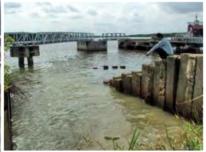
ベダン社の工場からティバイ川へ排水される汚水
