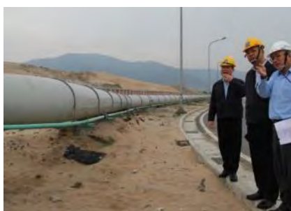
禁止されている酸を使って洗浄していた汚水処理プラントとフォルモサ社の責任者
