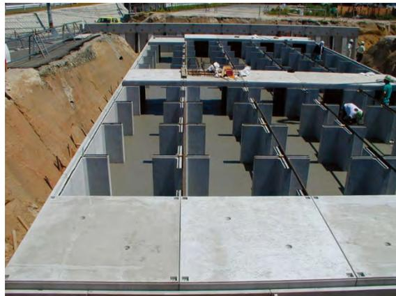
図8 プレキャスト雨水浸透施設
