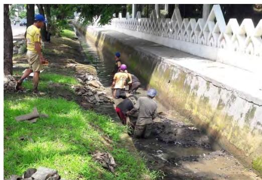
水路掃除は第2水路以下の小水路から行っている。機械による作業のほうが効率は良いが、作業する場所の周辺や道路状況により人力による作業も行っている。
