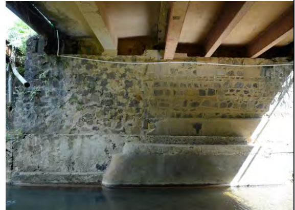
写真-2 既存橋下部左岸側より橋台ならびに桁下を望む
