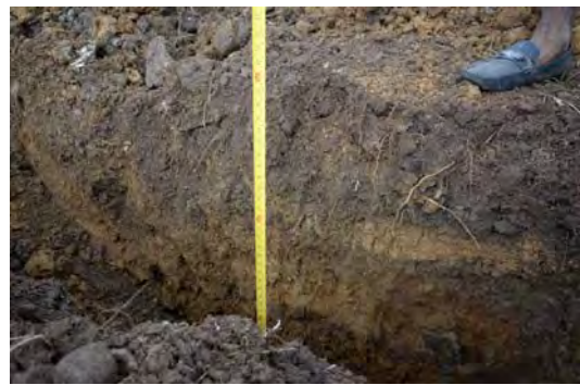
試掘面（カルデサック橋北側）
