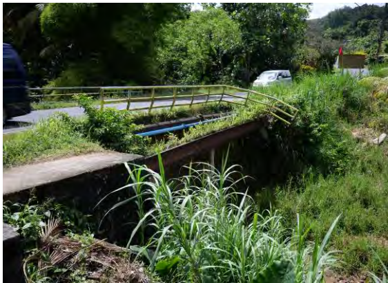
写真-3 橋梁左岸・上流側から既存橋を望む
