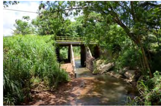
写真-2 既存橋下部左岸側より橋台ならびに桁下を望む
