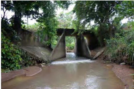
写真-1 下流側より既存橋を望む
