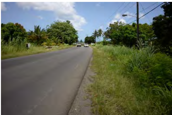
写真-5 東海岸道路東側より既存橋を望む
