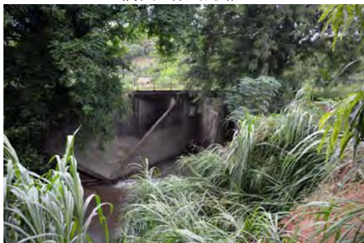
橋梁側面（下流側）
