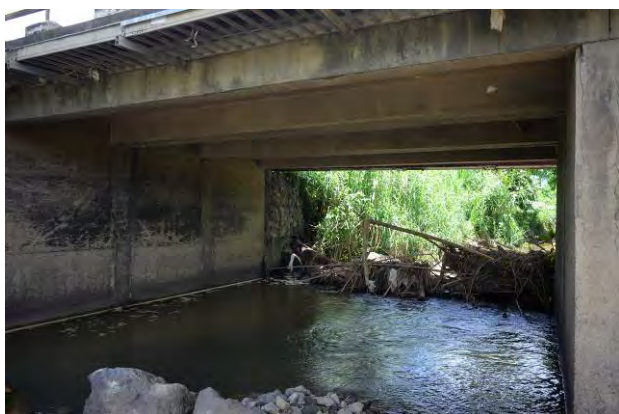
写真-3 下流側より右岸側開口部を望む
