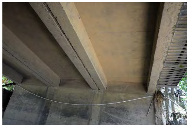
写真-2 橋梁下部より桁下を望む
