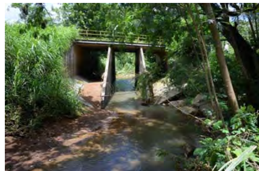
橋梁側面（上流側）
