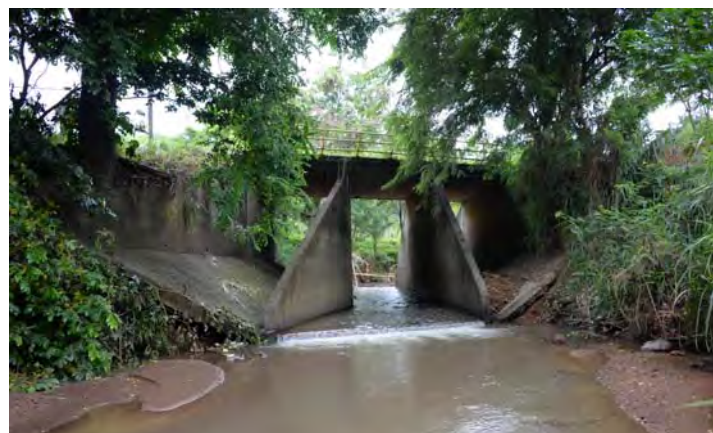
下流側からみたフェランズ橋
