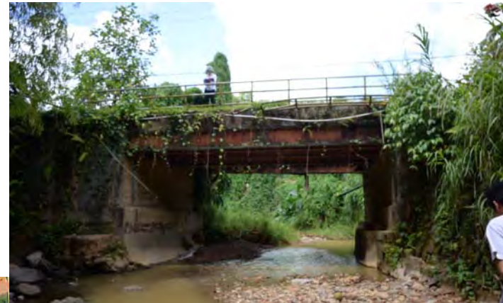
下流側からみたラヴィン・ポアソン橋
