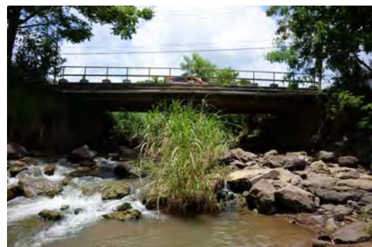
橋梁側面（下流側）
