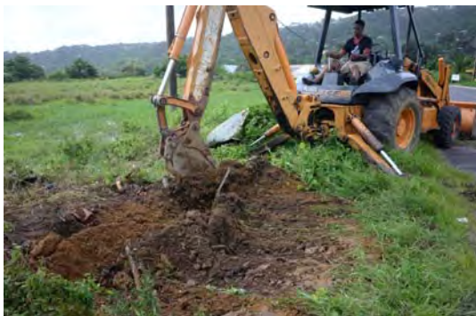
掘削状況（カルデサック橋北側）
