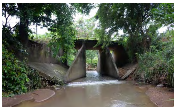
下流側からみたフェランズ橋
