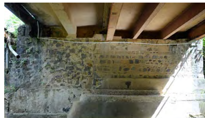
鋼 H 桁に鉄筋コンクリート T 桁で拡幅されている、橋台は石積み式
