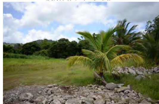
既存橋梁下流
