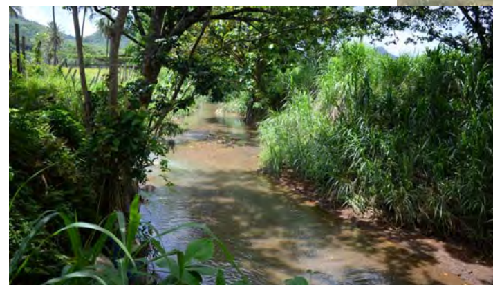
フェランズ橋上流部の状況 (通水断面は著しく不足している)
