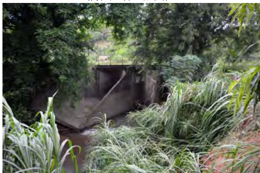
橋梁側面（下流側）
