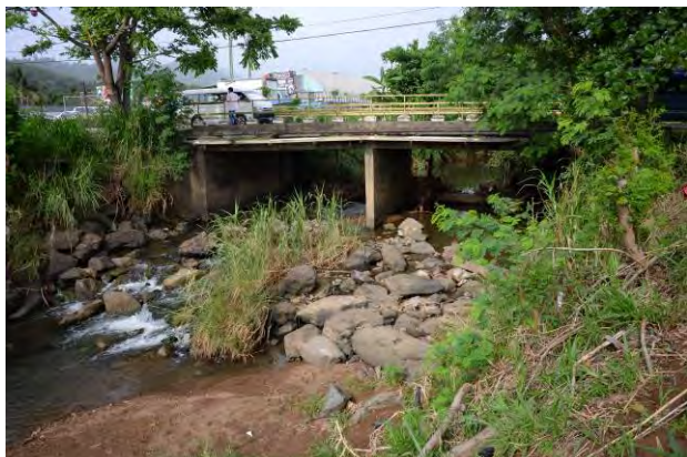
写真-1 下流側より既存橋を望む
