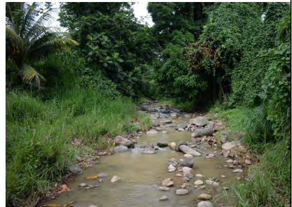
写真-4 既存橋から上流側を望む
