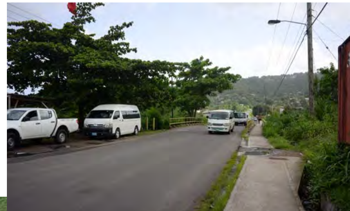
上流側に歩道を備える 2 車線道路・交通量は 8,000 台/日程度
