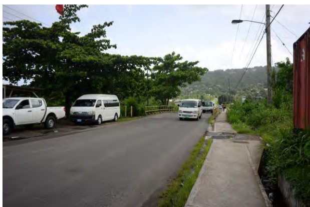
写真-5 既設道路南側より橋梁側を望む
