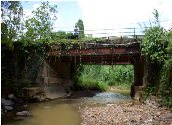
写真-1 下流側より既存橋を望む
