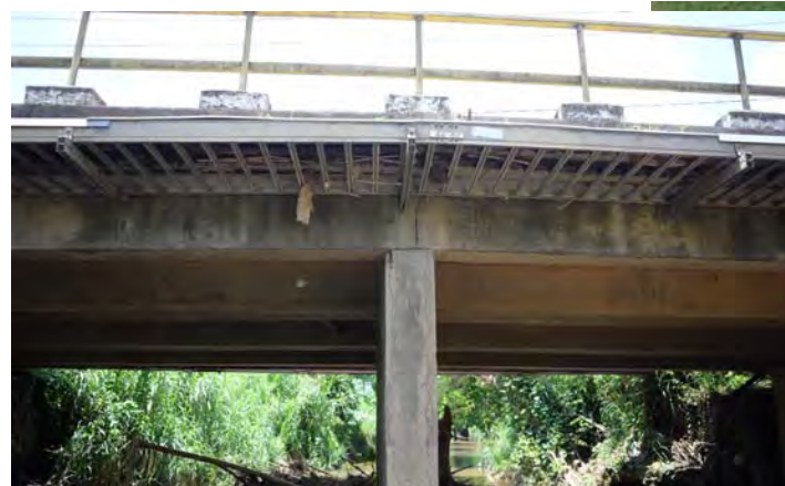
中央部の壁式橋脚
