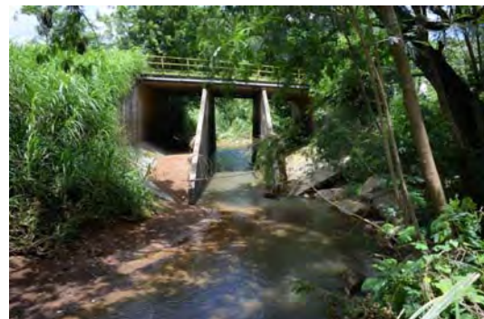
橋梁側面（上流側）
