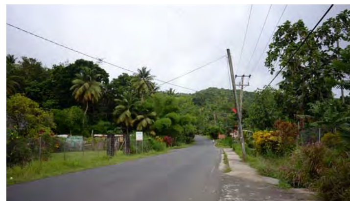
西側からラヴィン・ポアソン橋方面を撮影 交通量は約 4,800 台/日
