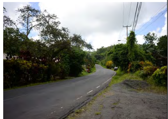
写真-6 既設橋右岸側より東海岸道路東側を望む
