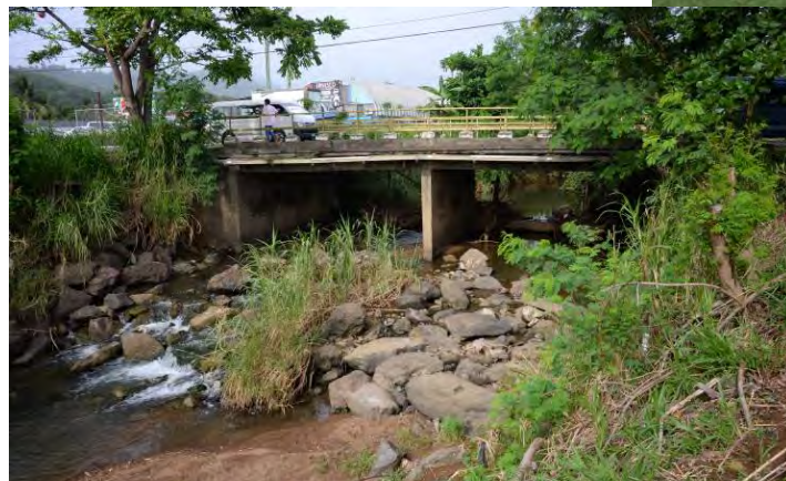
下流側からみたカルデサック橋
