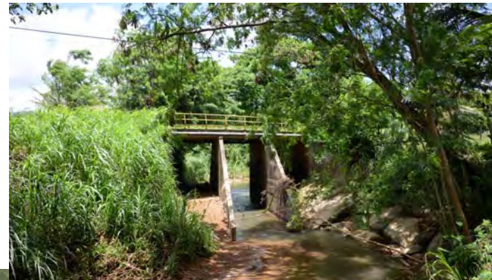
上流側からみたフェランズ橋 (一部に停留した浮遊物が認められる)
