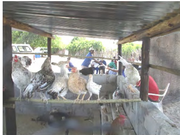
オムサティ州ツァンディ区でN-CLIMPの支援によって建設された改良型鶏舎 (撮影: 2016年2月8日)
