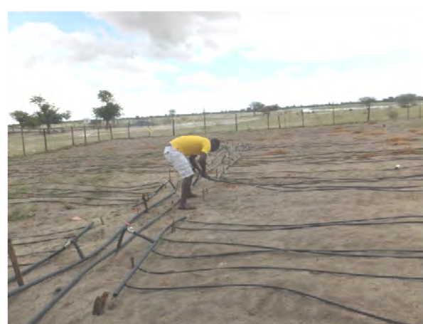
2017年2月12日パイロットサイトのオシャナ州オカタナ：経年劣化した既設の点滴灌漑施設の更新作業
