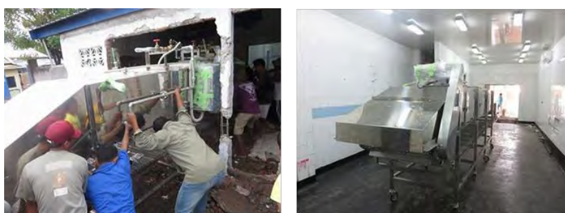
図 8 ペリカナンマカッサル工場への機材搬入
