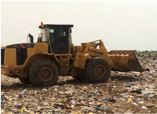
処分場における覆土作業
