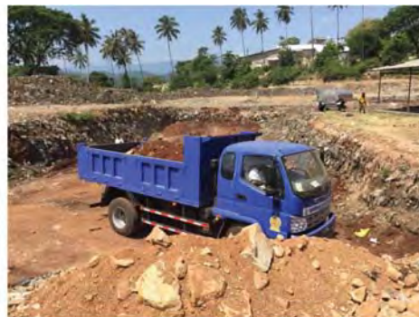
2015年6月埋設ゴミ処理状況
