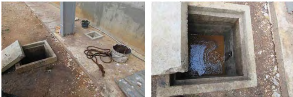
写真 26 排水枡からの排水
