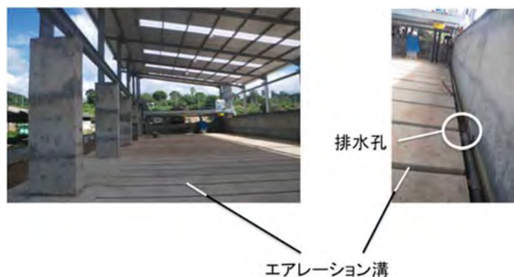
写真 16 エアレーション溝と排水孔
