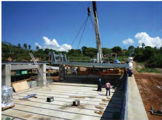
2015年10月16日 工場建設状況
