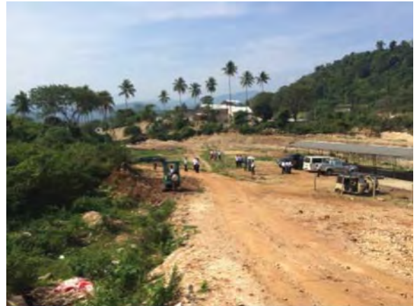
2015年3月9日 建設地全景
