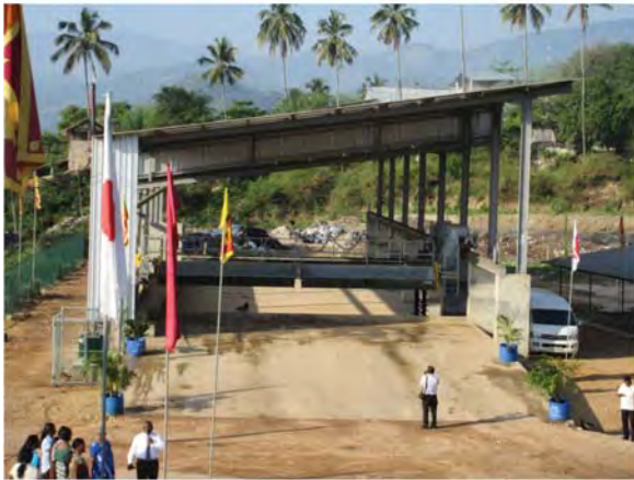
2016年4月29日 竣工式 プラント全景
