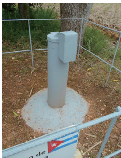
本プロジェクトで設置した観測井 JICA-3
