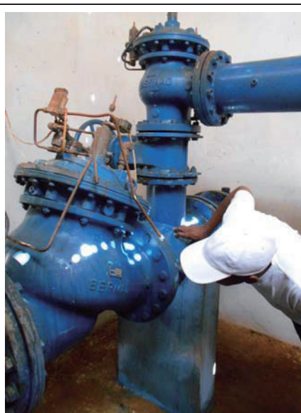
クエンカ・スル井戸 No.17 の内部。設備はイスラエル製。1981年に設置。半地下構造
