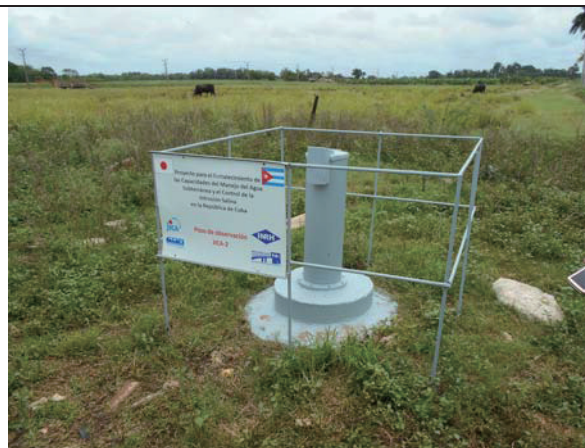
本プロジェクトで設置した観測井 JICA-2
