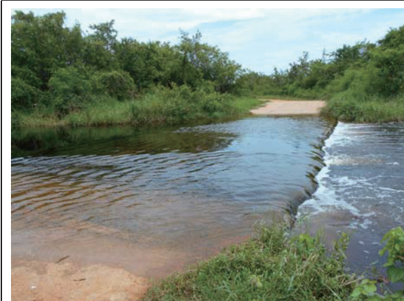
地下水涵養のため、海岸沿いに設置された堰堤
