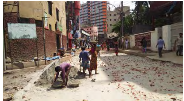
ダッカ市内の工事中の道路（表層は砂とレンガ）
