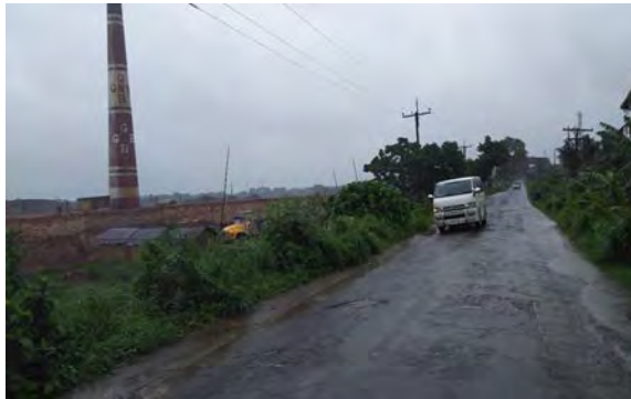
路盤が弱く傾いた地方道（ナラヤンゴンジ）
