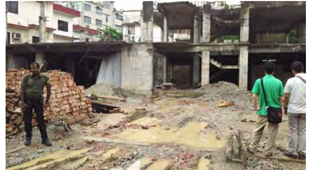
解体現場（基礎部分はコンクリートが多い）
