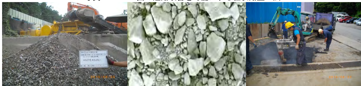
写真 2-1. バ国の道路改善を可能にする粒状路盤工法
