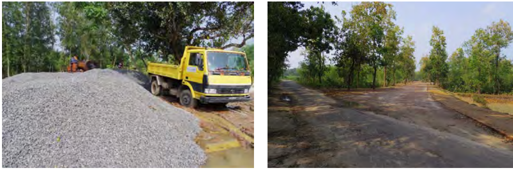
写真左：スリプールのウポジラ道路工事現場 路盤材置き場（自然石材） 右：ガジプールのウポジラ道路工事現場 表層舗装前
