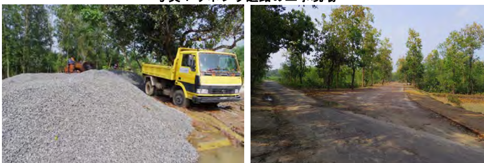
写真左：スリプールのウボジラ道路工事現場 路盤材（自然石材）置き場 右：ガジプールのウボジラ道路工事現場 表層舗装前
