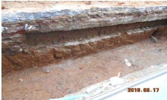
ボナニ地区道路の断面（側溝工事中）
