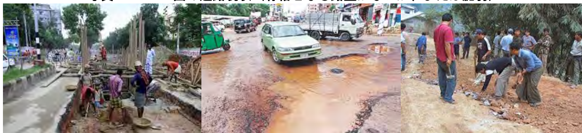
写真 1-1. バ国の道路現状（骨格となる路盤がないか、または脆弱）
