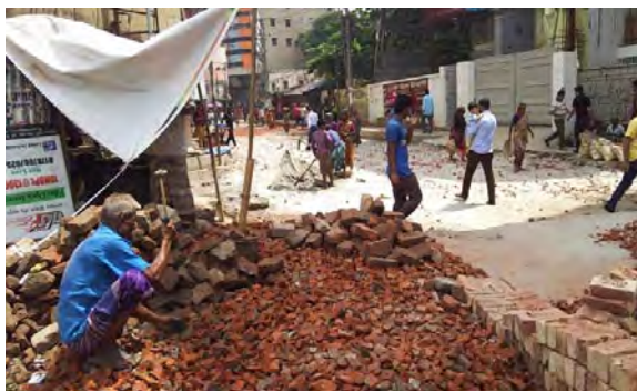
写真：左レンガを砕いてレンガチップを製造、 右レンガ材を敷き詰める作業
