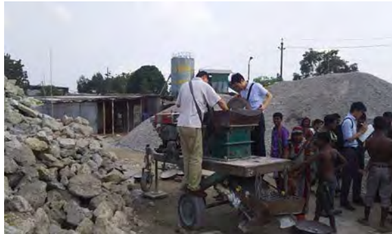
コンクリート廃材の破碎機を（解体業者）
