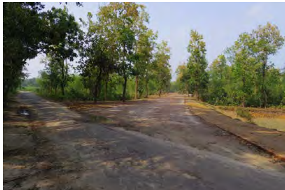
ガジプールの道路工事現場（舗装前）
