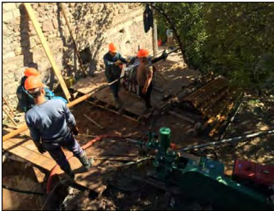
排水ボーリング 供与機材であるボーリングマシンを使用したパイロット事業地区（ゲタホビット）におけるボーリング作業状況
