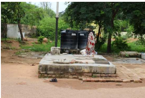
既存セプティックタンク
