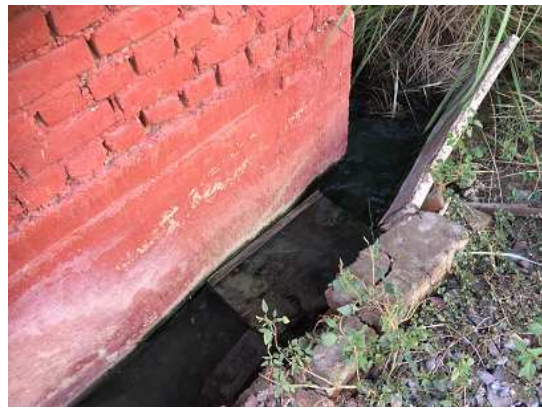
学生寮、校舎からの排水溝
