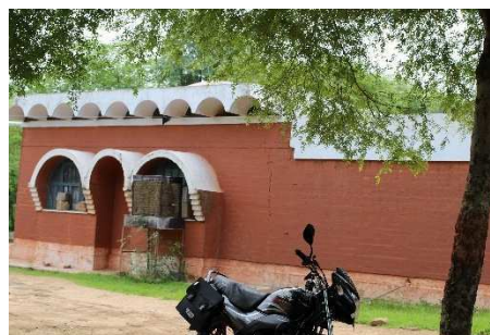
事務棟付近候補用地
