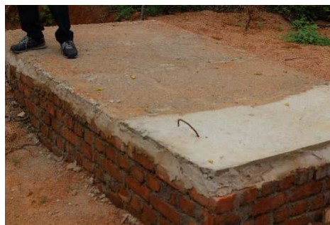
新設セプティックタンク
