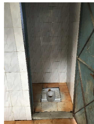
トイレ内部の様子
