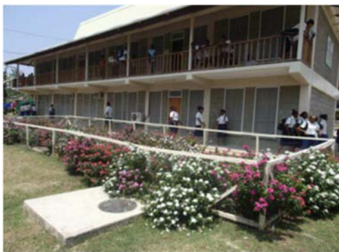
写真 2：学校に設置した TSS の土壌処理上部の植栽の繁茂（ソロモンでの実証試験結果）
