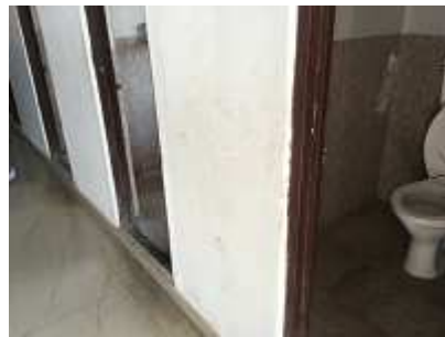
学生寮トイレ内観
