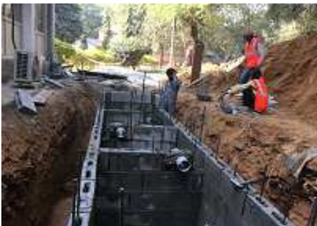
デモ機設置工事の様子
