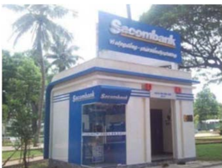
写真 16 : 多目的トイレの例 (ベトナム)
