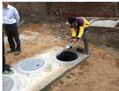
デモ機の処理水質測定の様子
