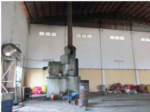
写真 5：現地調査 赤十字焼却炉
