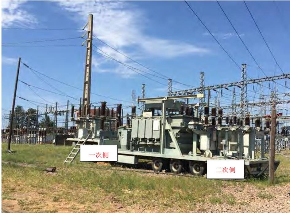
図 3-2-1-2-1.1 EDM の運用する欧州製 66/33 kV 移動式変電所 (10 MVA) の運転状況
