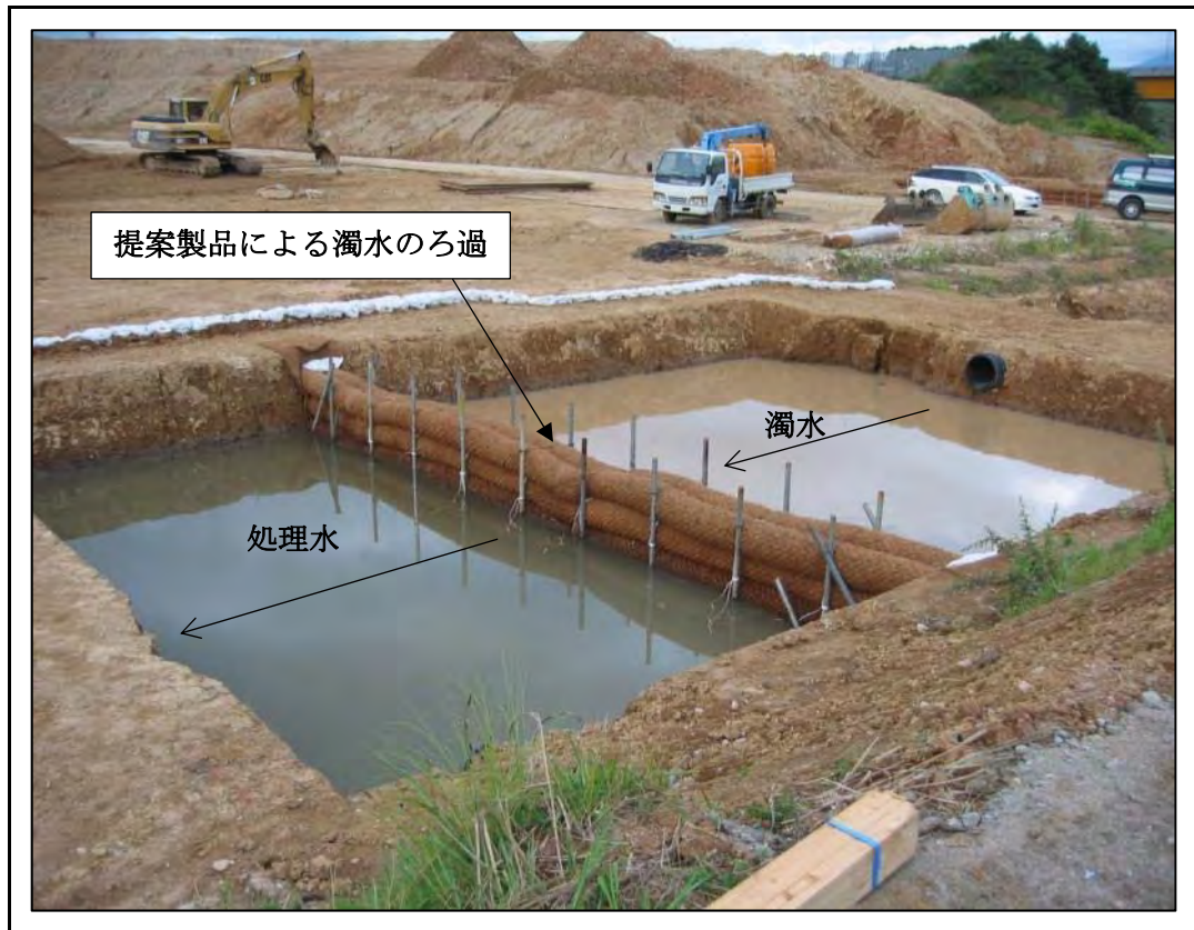
写真 5.5 建設現場の濁水処理施設(沈砂池)のろ過材として使用されている提案製品
