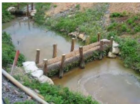
排水路の濁水処理
