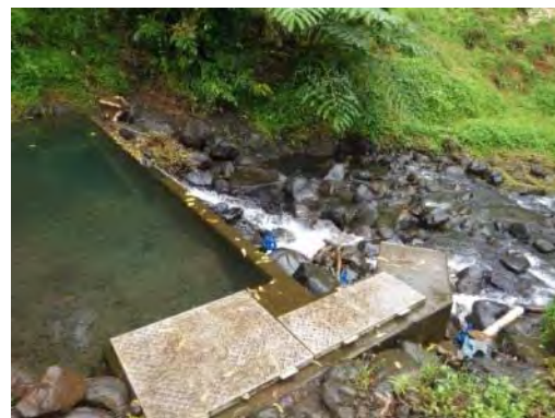
写真 3. 17 取水施設の外観
