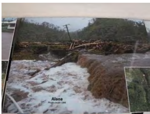
橋の倒壊(アラオア)
