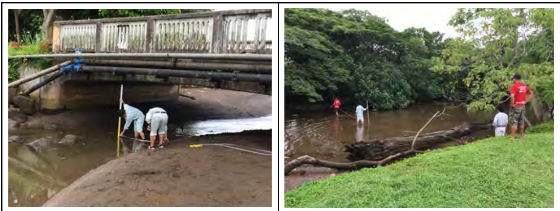
写真 3.80 「Fagalii tai outlet -5」の橋梁付近及び中流部の簡易測量の状況
