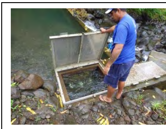
写真 3. 18 取水施設の内部
