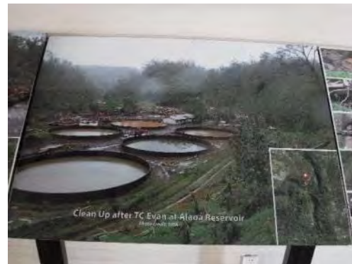
アラオア浄水場の被害
