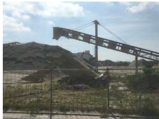
写真 2.3(2/2) 敷地内の状況
