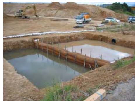
造成工事の濁水処理
