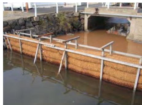
河川工事の濁水処理
