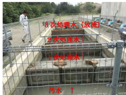
写真 2.4(2/2) 濁水処理の状況
