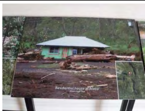
住宅への被害(アラオア)
