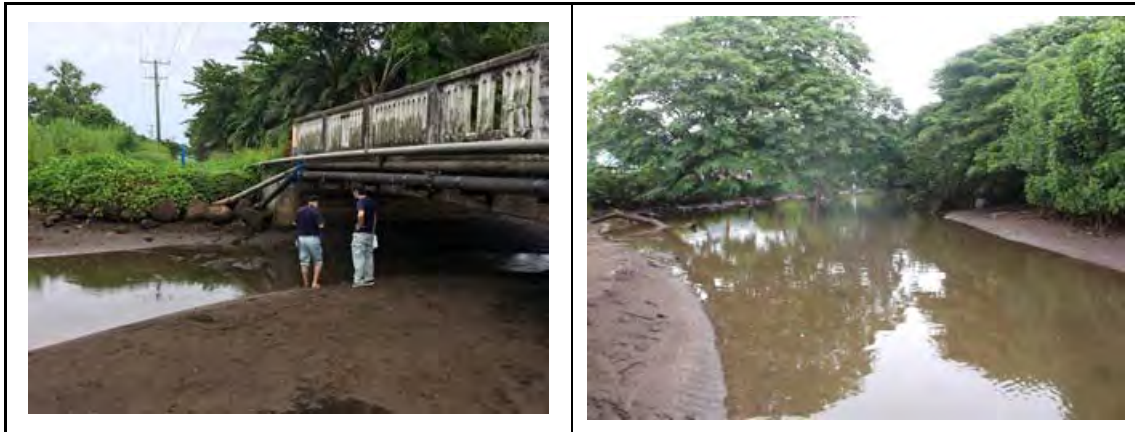
写真 3.82 「Fagalii tai outlet-5」の橋梁付近及び中流部の土壌堆積の状況
