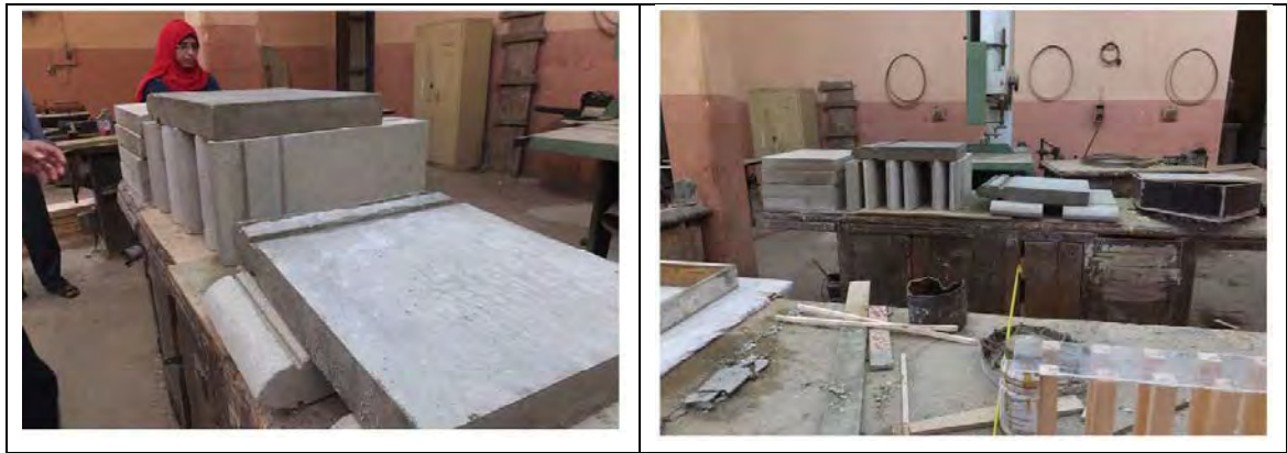
図 3-2.7 既存堰の製作現場（大規模堰のピアの製作）
