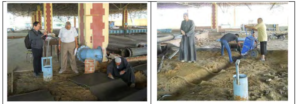
図 3-2.8 現況水路の製作現場（モルタル施工）
