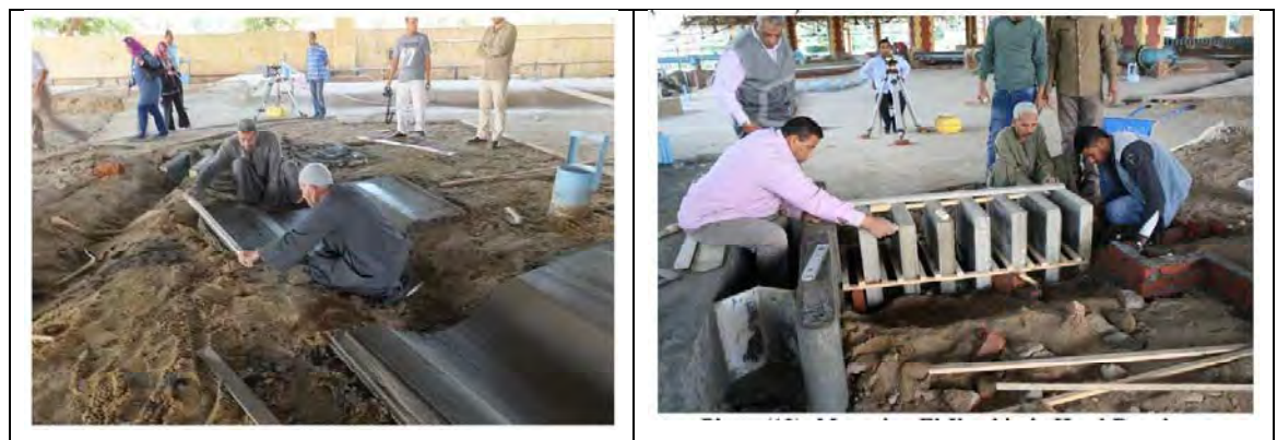
図 3-2.9 現況水路の製作現場（現況水路の施工と大規模既存堰の設置）
