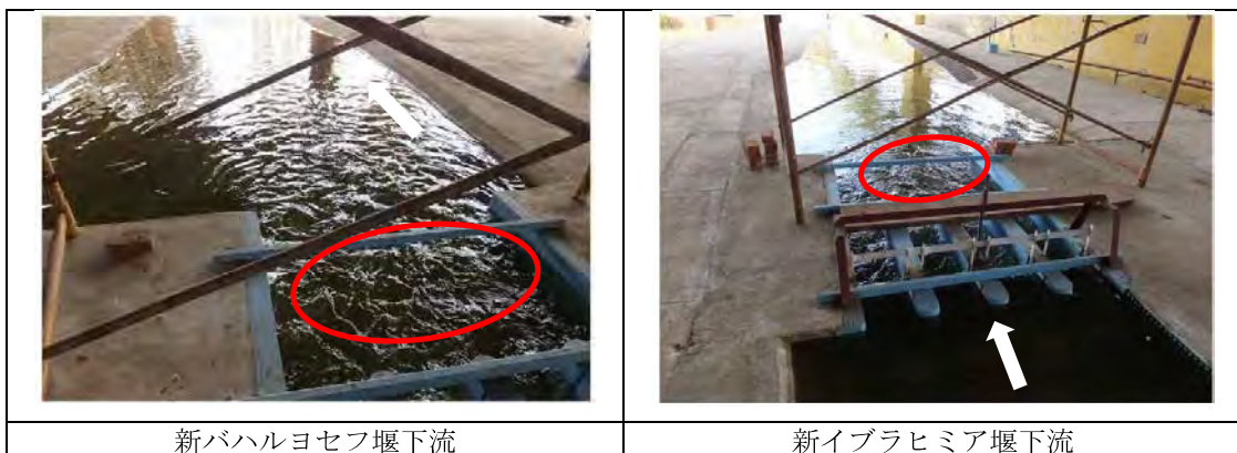
図 3-2.20 計画時における既存堰下流の流れの状況 (乱れている)
