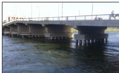
図 1-1.6 橋梁の上流の状況 (B8 橋梁)
