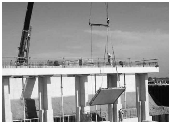
図 18-3.1 扉体の吊り込み方法 (小規模堰)
