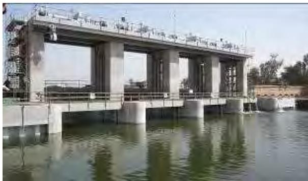
現況写真 5：鋼製越流型二段式ゲート遠景 (ダハブ堰)
