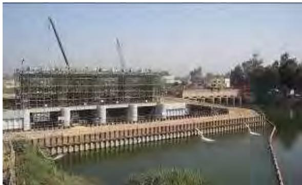
現況写真 7：鋼矢板二重締切工法
