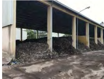
・二次発酵槽
