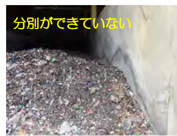
・一次発酵槽(拡大)
