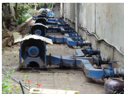
・一次発酵槽用給気装置（ハノイ KieuKy 工場）
