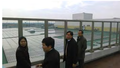
・施設屋上の太陽光発電パネル
