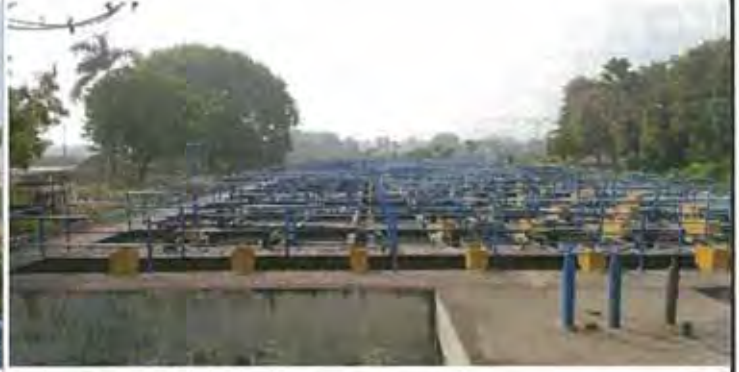
Note) 4-Dec-2015 MirzapurSTP-2 UASB Reactor
