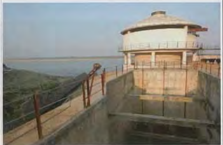
Note) 30-Sep-2015 Varanasi NagwaPS-4 Existing Nagwa PS
