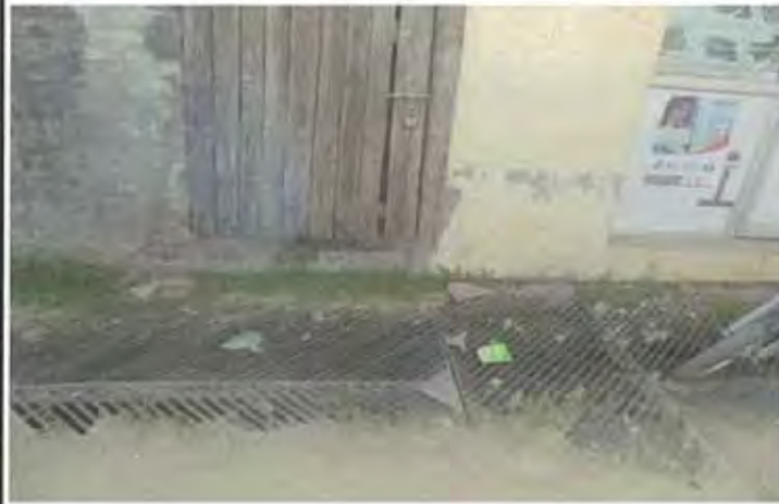
Note) 28-Sep-2015 Ramnagar-1 Drainage
