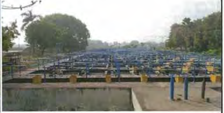
Note) 4-Dec-2015 MirzapurSTP-2 UASB Reactor
