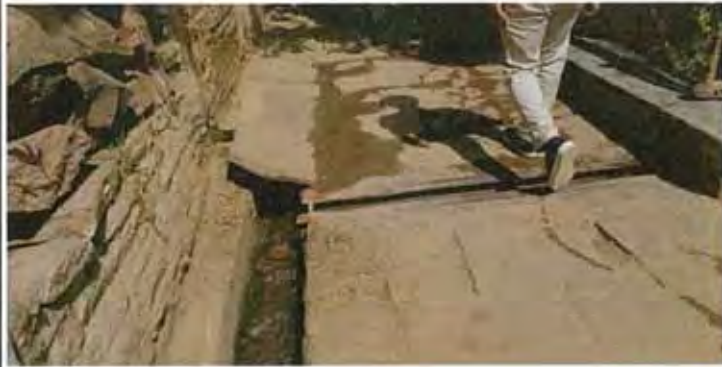
Note) 26-Sep-2015 Chunar-1 Drainage
