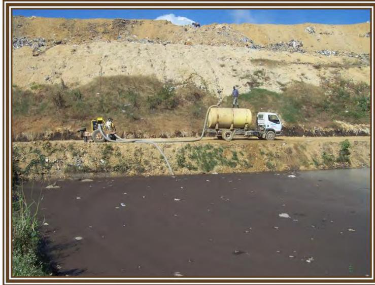
**Foto 34 Recirculación de lixiviado en la masa de residuos**
