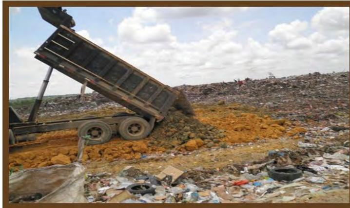
**Foto 27 Vaciado del material de cobertura**
