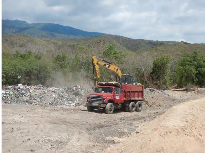
**Foto 19 Carga y transporte de residuos en camión volteo en el SDF de Azua**
