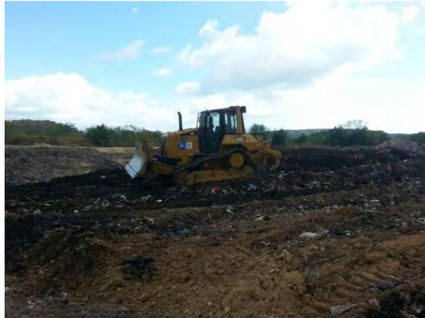
**Foto 24 Esparcimiento y compactación de residuos con buldócer en el SDF de Azua**
