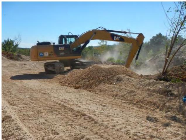
**Foto 17 Excavación de material de cobertura en el vertedero de Azua**
