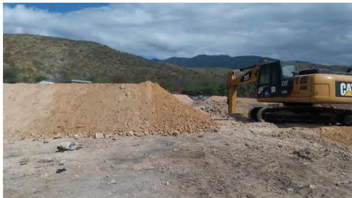
**Foto 18 Construcción con excavadora del muro de contención durante la rehabilitación del vertedero de Azua.**
