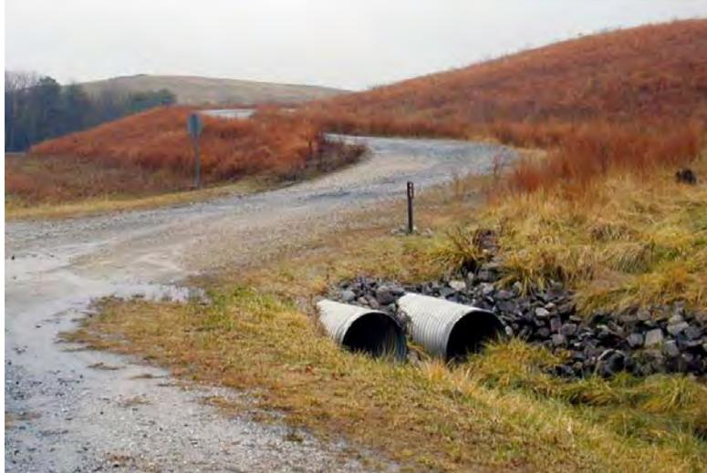
**Foto 35 Alcantarrilla de aguas pluviales en un relleno sanitario**
