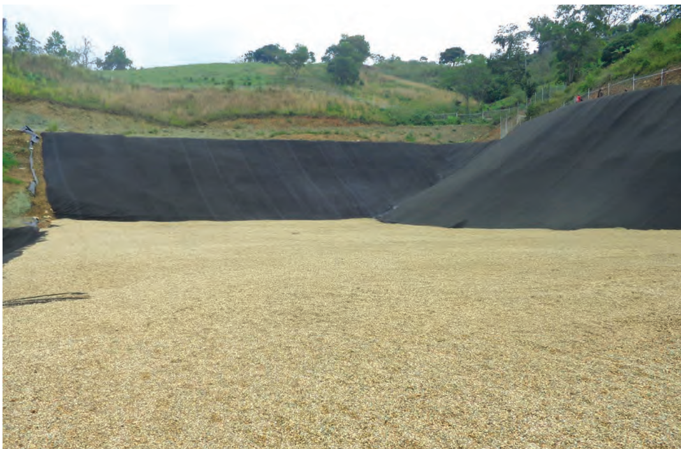
Construcción del vertedero controlao de Villa Altagracia
