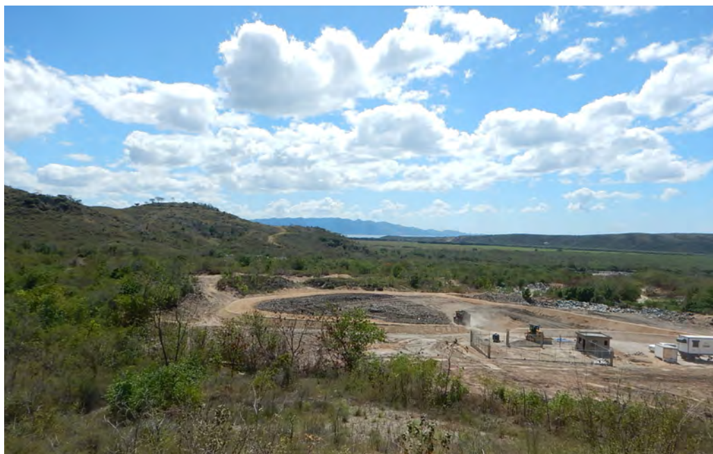
Vertedero de Azua en proceso de rehabilitación
