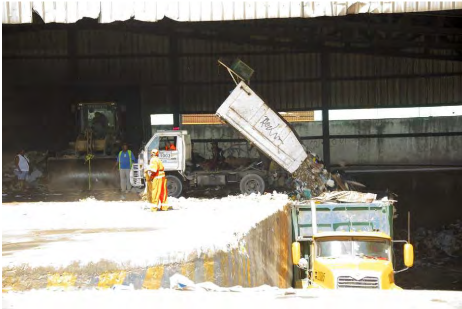
Foto 7 Descarga en la Estación de Transferencia en Villas Agrícolas, ADN
