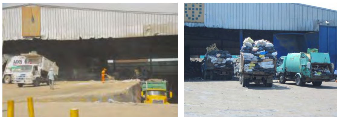
Foto 12 Vista de la ET y de los camiones recolectores y de transferencia
