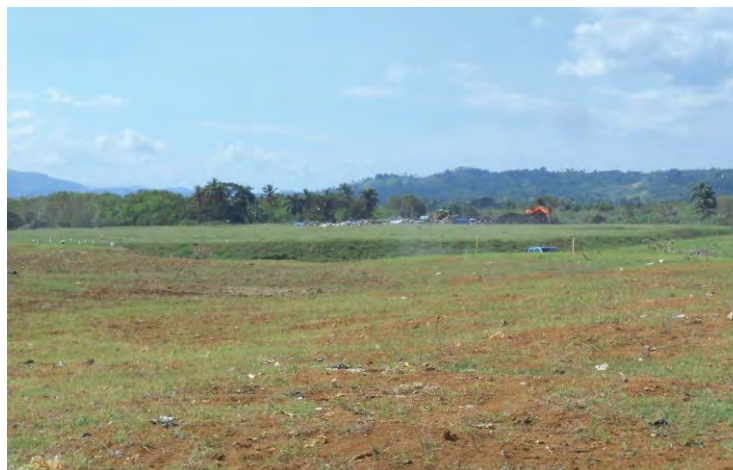
Figura 11 Adecuación del vertedero de La Vega
