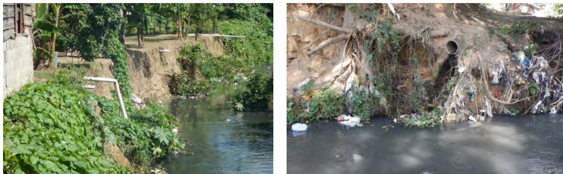
Figura 6 Puntos de descarga de las aguas residuales del asentamiento del lado norte
