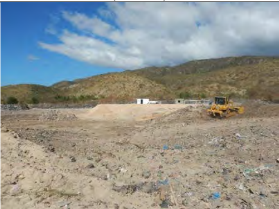
アスア処分場での運営指導 (建設中の小堰堤、ブルドーザーによる整地) (2017.2.6)
