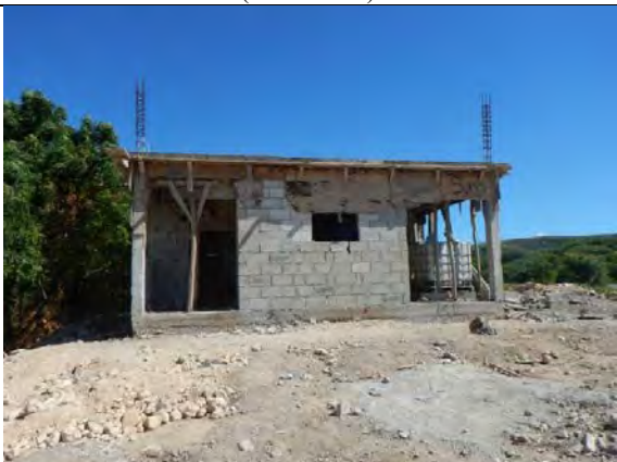
アスア運営指導：処分場入口の監視小屋（建設中） (2016.11.28)
