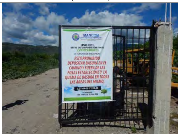
アスア運営指導：設置された既存処分場入口ゲート
