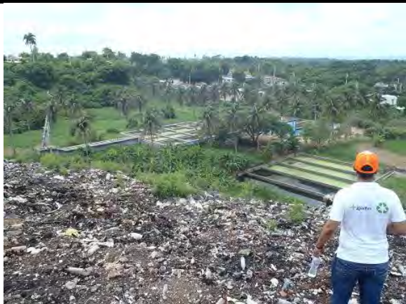
既存処分場の現地踏査 (モカ市) (2015.11.3)
