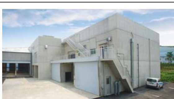
図 1 桃山リサイクルセンター（外観）
