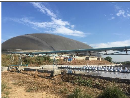
養豚場のバイオガス施設
