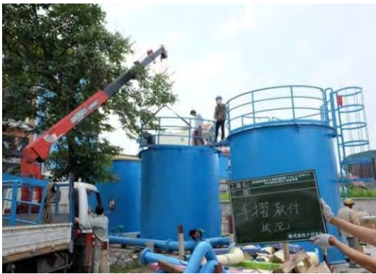
手摺取付状況（平成 28 年 6 月）
