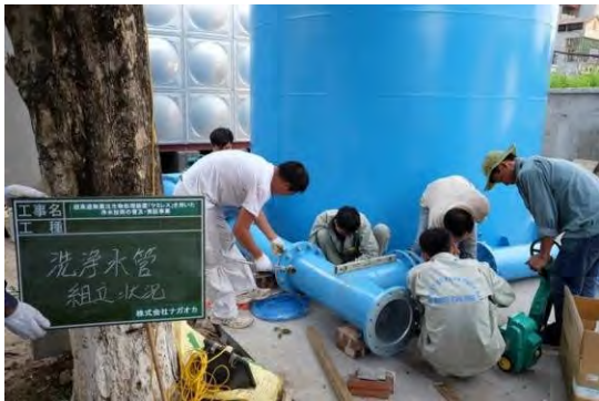
洗浄水管組立状況（平成 28 年 6 月）
