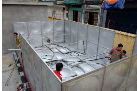
洗浄水槽設置作業（平成 28 年 5 月）
