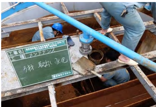
メンテナンス指導状況（平成 29 年 4 月）
