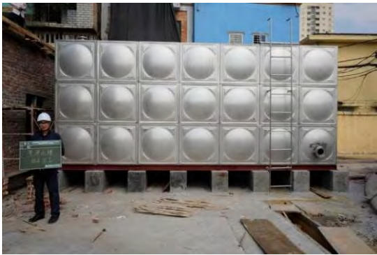
洗浄水槽設置完了（平成 28 年 5 月）
