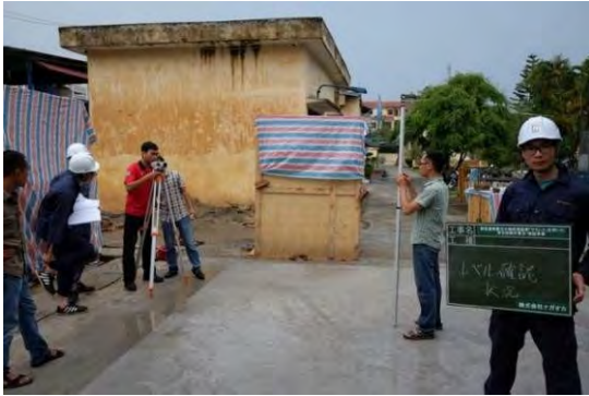
レベル確認状況（平成 28 年 5 月）
