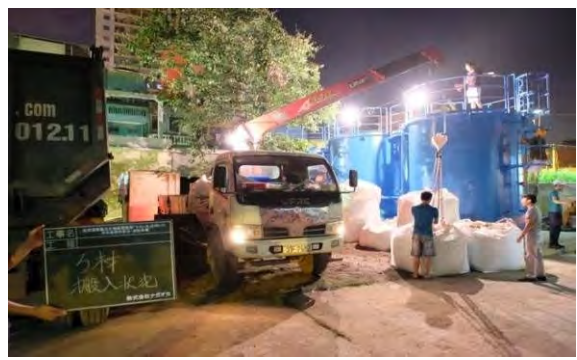
ろ材搬入状況（平成 28 年 6 月）
