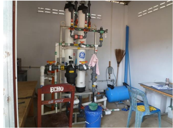
写真 3- 6 2015 年にローカル NGO の支援により設置された軟水処理システム(GE 社製)
